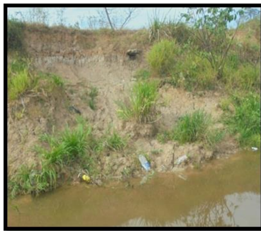
Presencia de material flotante en el cuerpo hídrico y erosión del cauce
