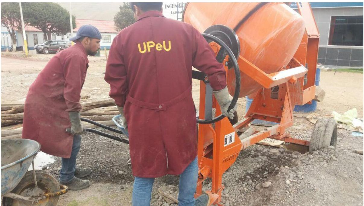
**Fotografía 14.** *Colocación del concreto en el buggy.*
