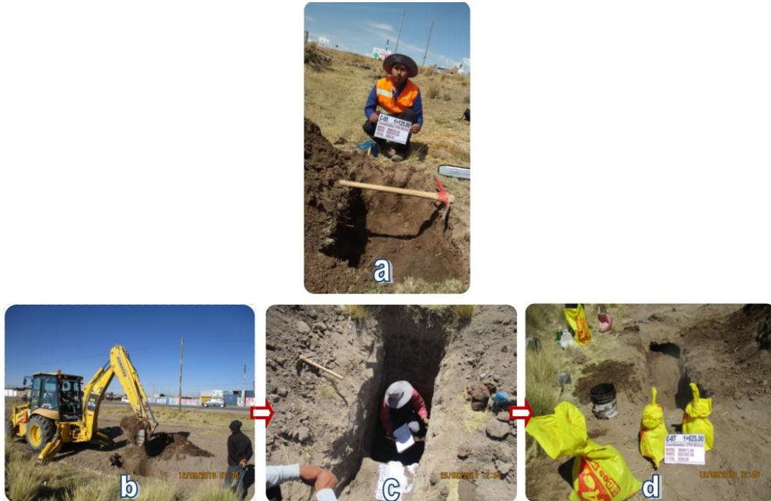
(a): Excavación inicial de 0.5 +/- 0.10m, para comienzo del ensayo de PDC. / (b): Excavación de calicata con maquinaria. / (c): Registro del perfil estratigráfico del suelo. / (d): Extracción de muestras para ensayo en laboratorio.
