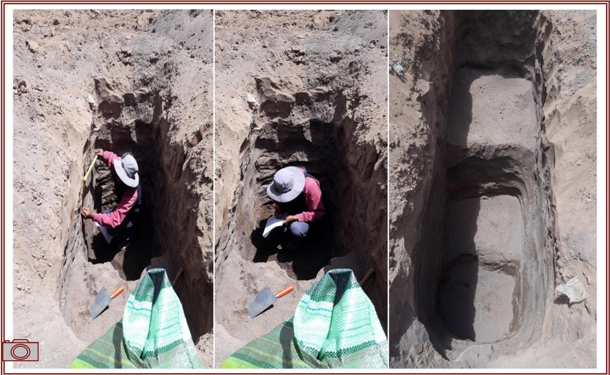
**Fotografía 3.** Exploración manual y registro del perfil estratigráfico en calicatas.
