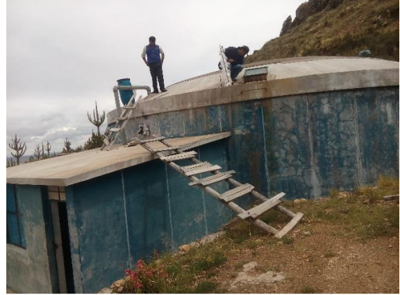
Fotografía 6. Limpieza de los bordes del reservorio, antes de la toma de muestra
