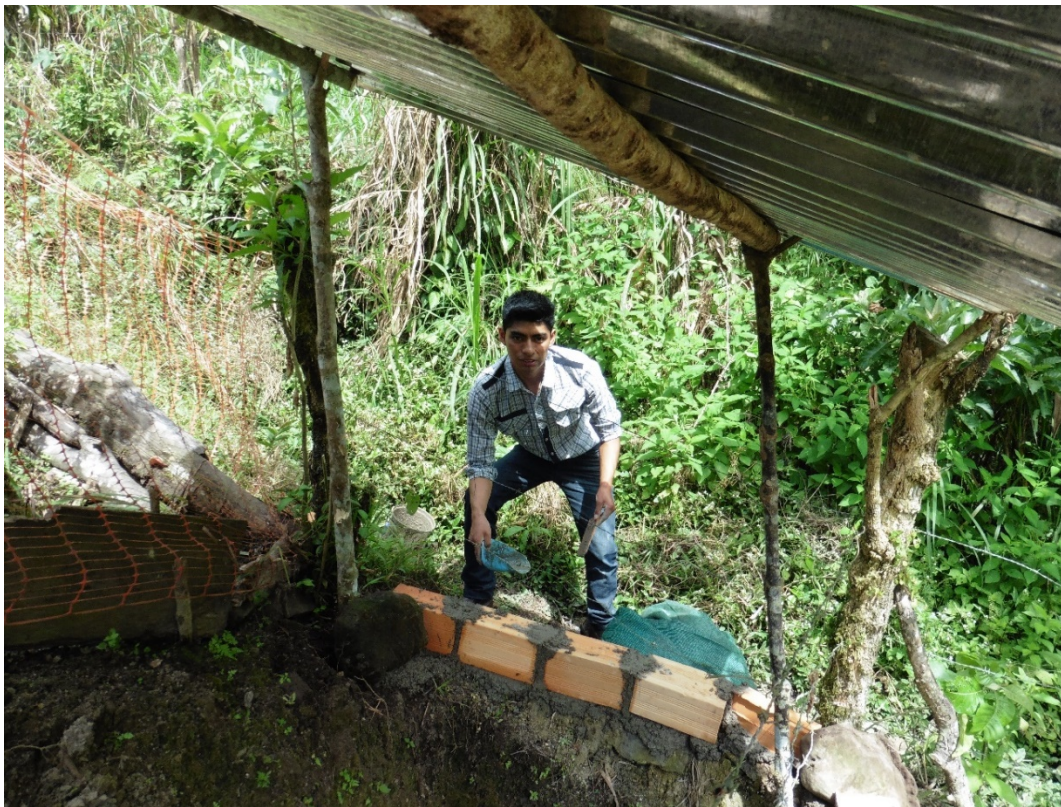
Figura 104 - Taller de construcción de micro relleno sanitario
