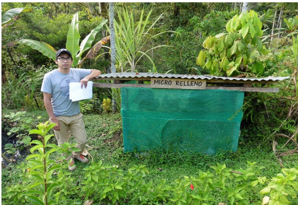
Figura 105 - Micro relleno sanitario domiciliario
