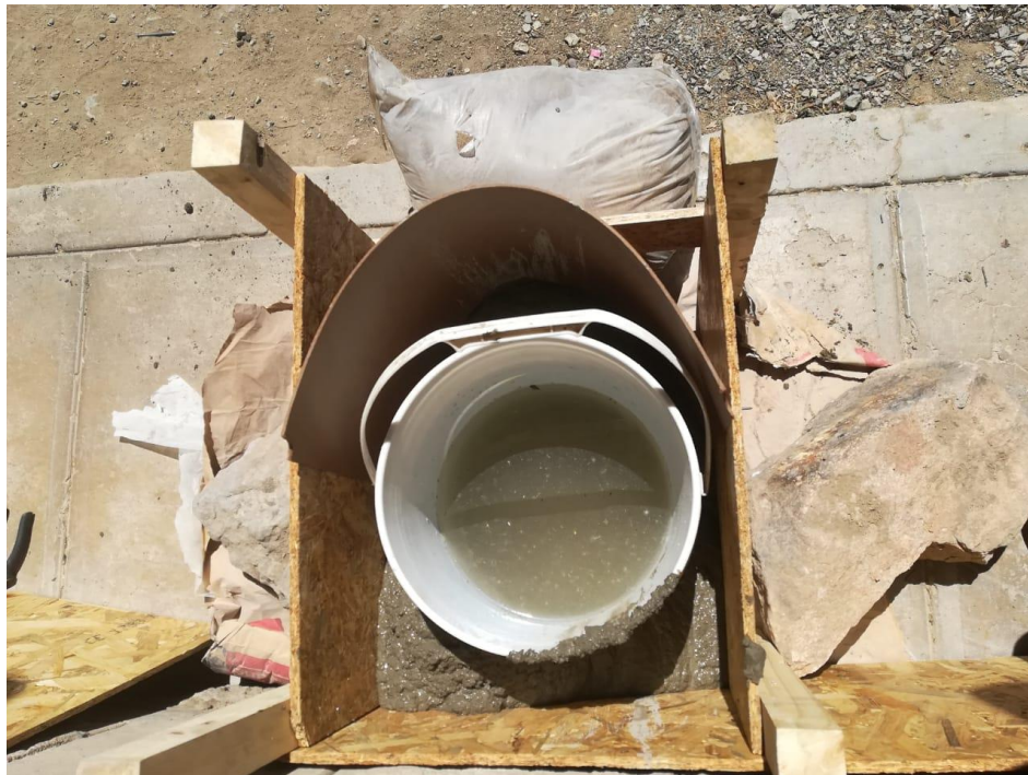
Figura 74: Vaciado de cemento en el molde. Fuente (Huawei P9, 2018)
