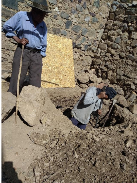
Figura 65: Inicio de trabajo cavando el hueco. Fuente (Huawei P9, 2018)
