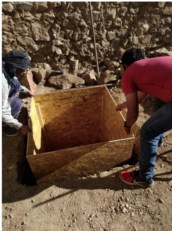
Figura 68: Instalación del encofrado. Fuente (Huawei P9, 2018)
