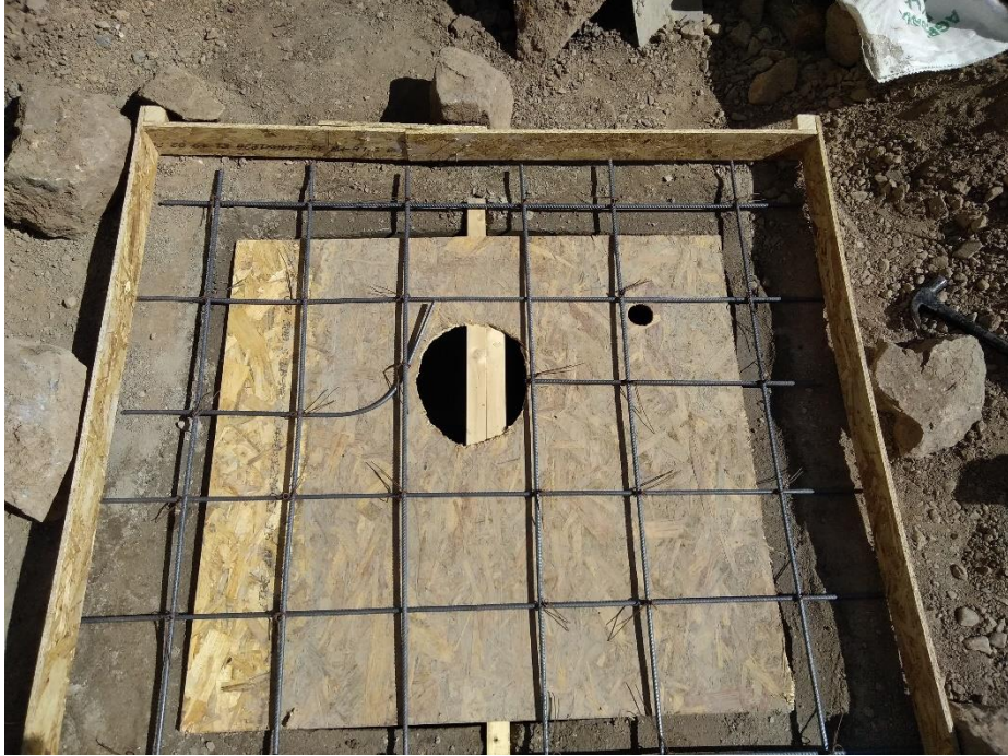
Figura 69: Molde para loza, después del vaceado. Fuente (Huawei P9, 2018)
