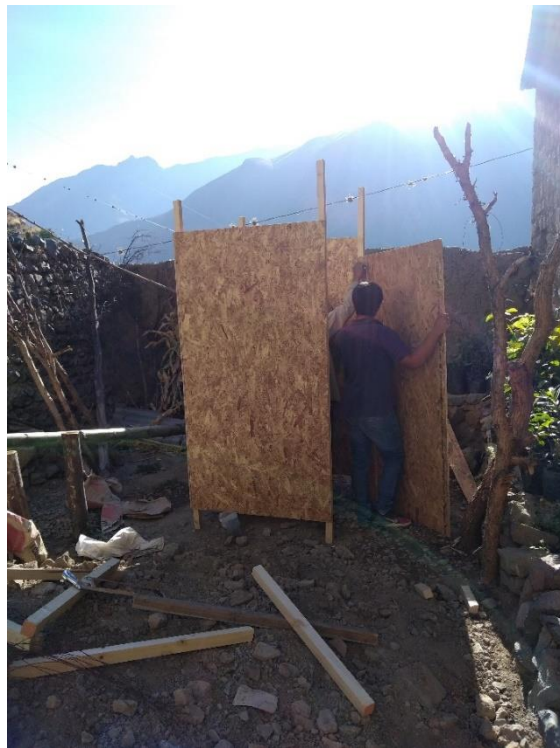
Figura 70: Armado de la letrina. Fuente (Huawei P9, 2018)
