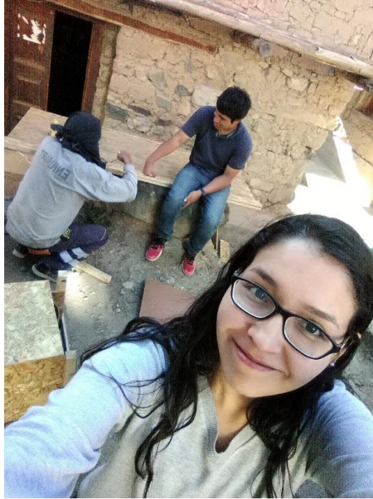
Figura 71: Armado de paredes y listones de letrina. Fuente (Huawei P9, 2018)
