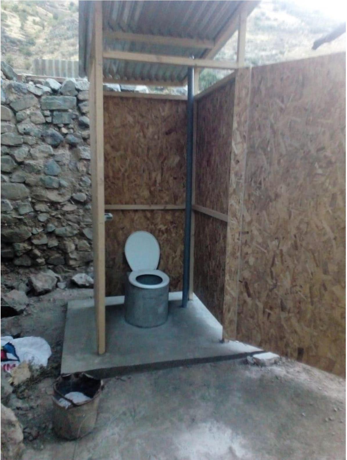
Figura 76: Letrina ecológica seca terminada. Fuente (Huawei P9, 2018)
