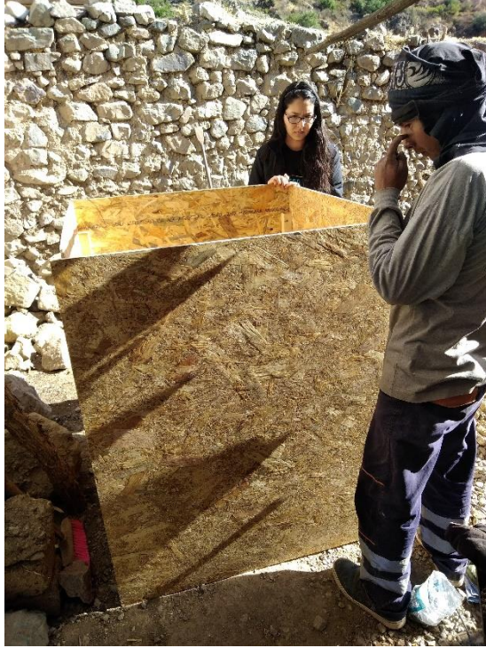
Figura 67: Armado del encontrado para las paredes del hueco. Fuente (Huawei P9, 2018)
