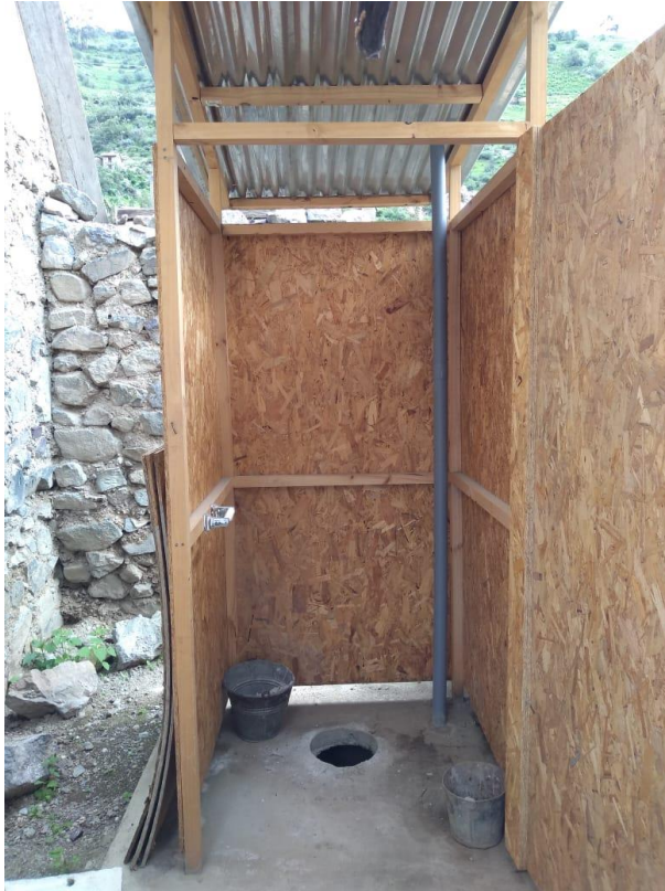
Figura 79: Estado del Bañito casi 7 meses después. Fuente (Huawei P9, 2019)
