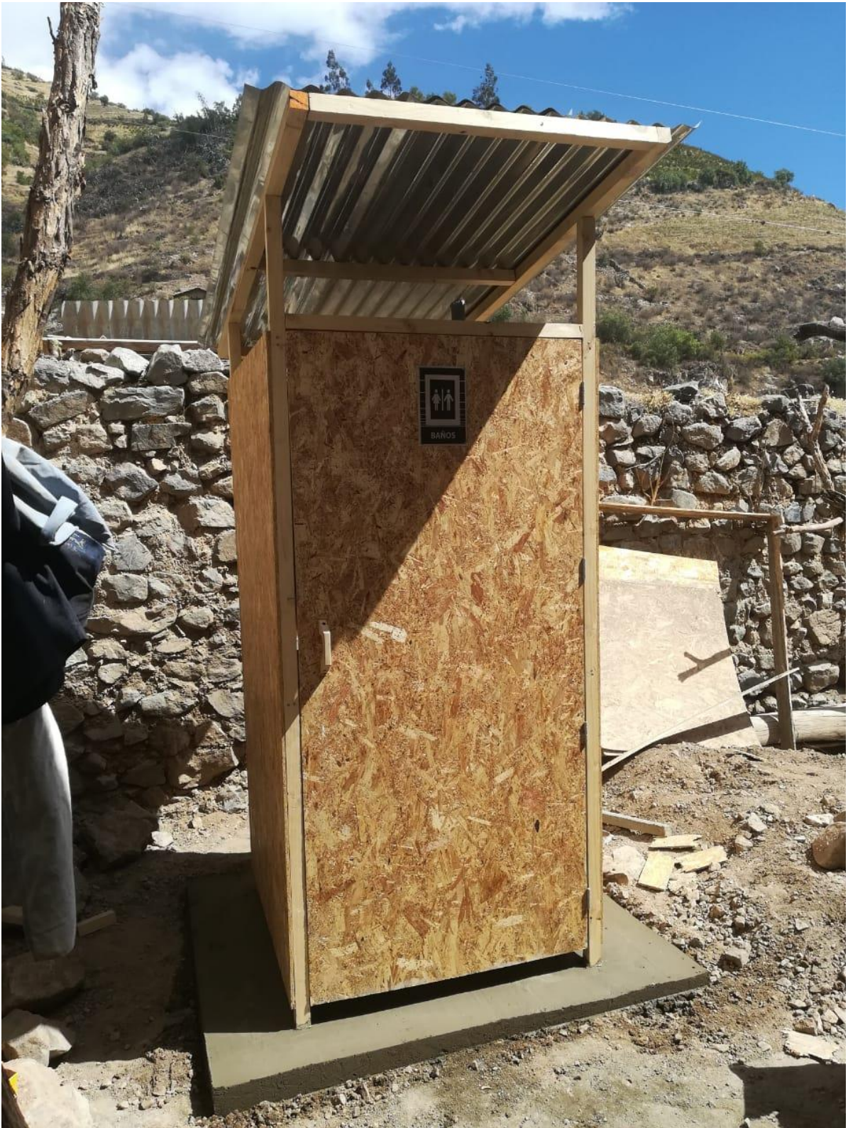
Figura 75: Letrina ecológica seca terminada. Fuente (Huawei P9, 2018)
