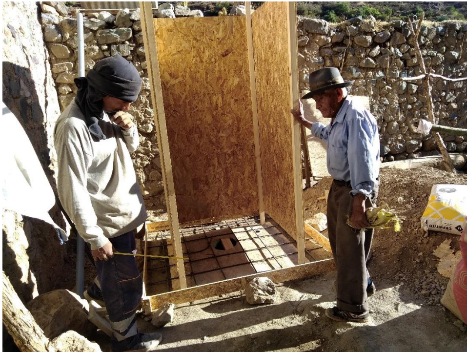
Figura 72: Instalación de letrina antes del vaciado. Fuente (Huawei P9, 2018)
