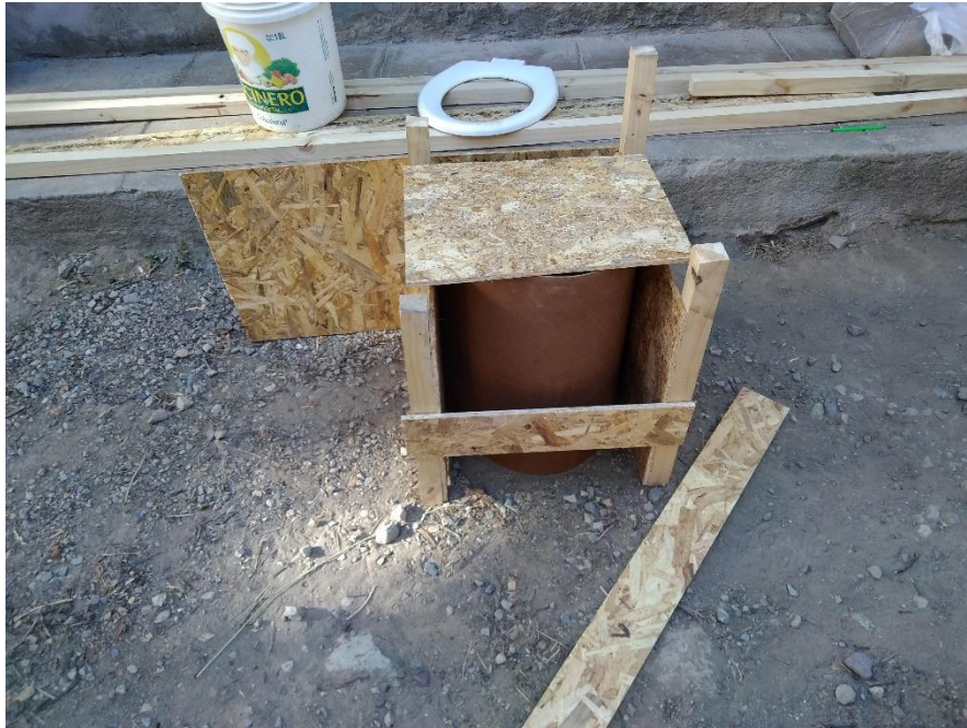
Figura 73: Elaboración del molde de la taza. Fuente (Huawei P9, 2018)
