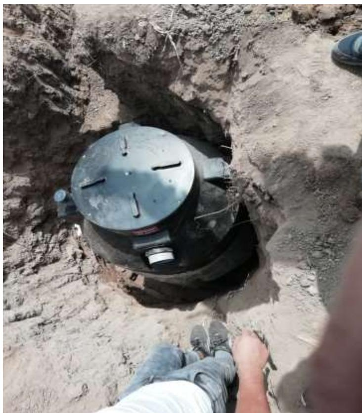
*Figura 48.* Biodigestor instalado.
