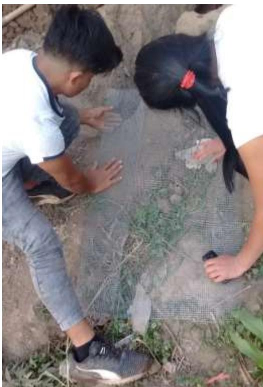
*Figura 52.* Preparación de cernidor para rellenar el biodigestor.
