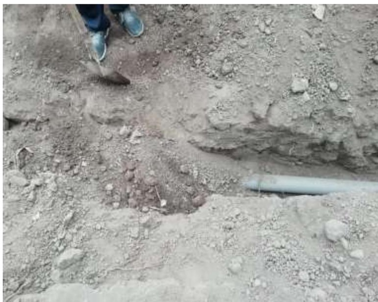
*Figura 47.* Entierro de tubería de desagüe.
