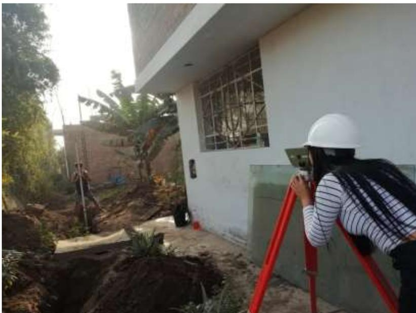
*Figura 42.* Topografía de lugar, fijación de pendiente del 10% para la tubería.
