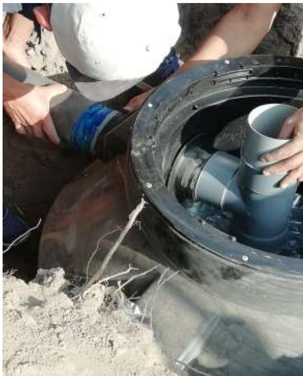
*Figura 46.* Pegamento de la tubería en el biodigestor.
