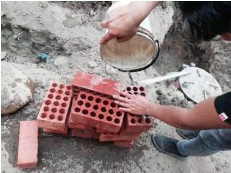
*Figura 50.* Preparación de ladrillo para la caja de lodos.
