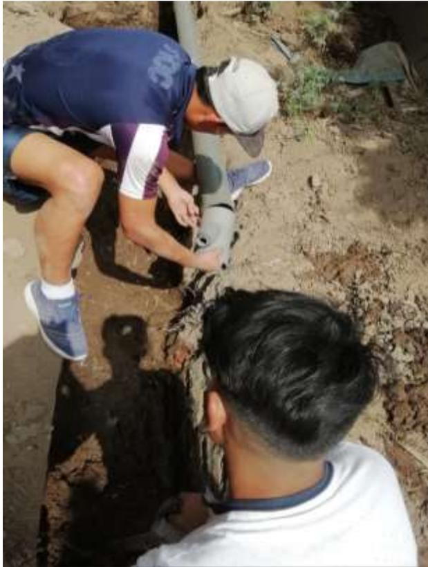
*Figura 45.* Instalación y pegamento de tubería de desagüe.
