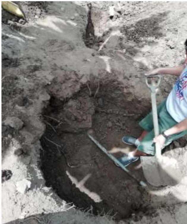
*Figura 38.* Excavación de zanja para biodigestor.
