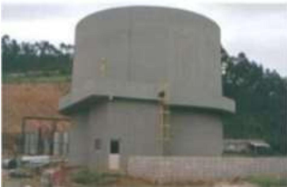
*Figura 8.* Sistema Biodigestor tipo Batch .Hernández, Fernandez, y Baptizta. (2006).
