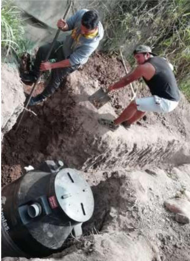
*Figura 49.* Excavación para caja de lodos.
