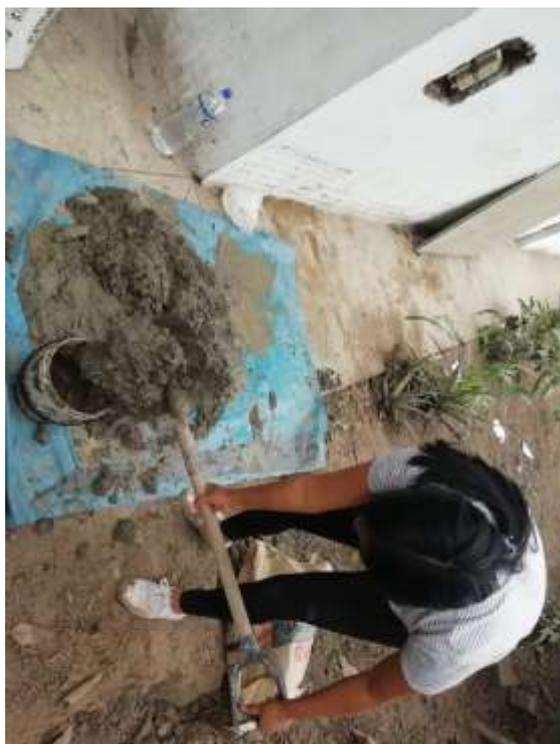
*Figura 51.* Mezcla de cemento para caja de lodos.
