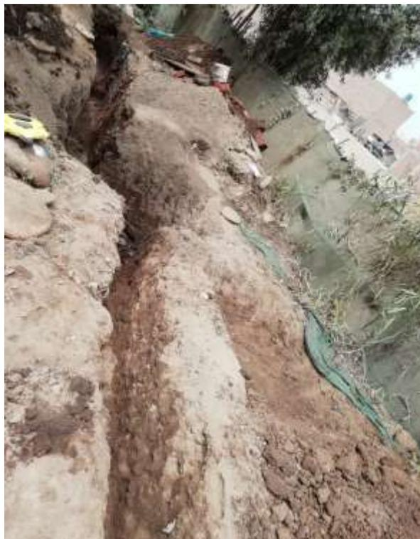
*Figura 40.* Terreno excavado para instalación de tubería.
