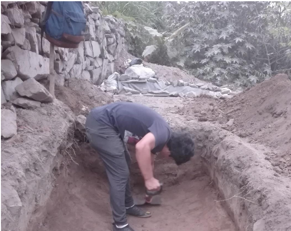
Figura 65. Excavación para la instalación del sistema de tratamiento HAFSSH
