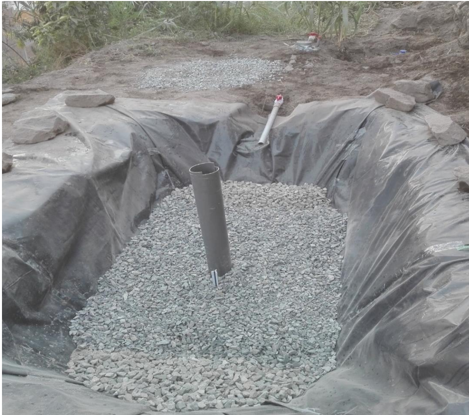
Figura 72. Instalación de la tubería de aireación
