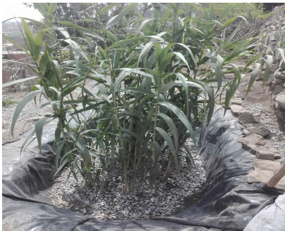
Figura 79. Plantación terminada del carrizo en el HA
