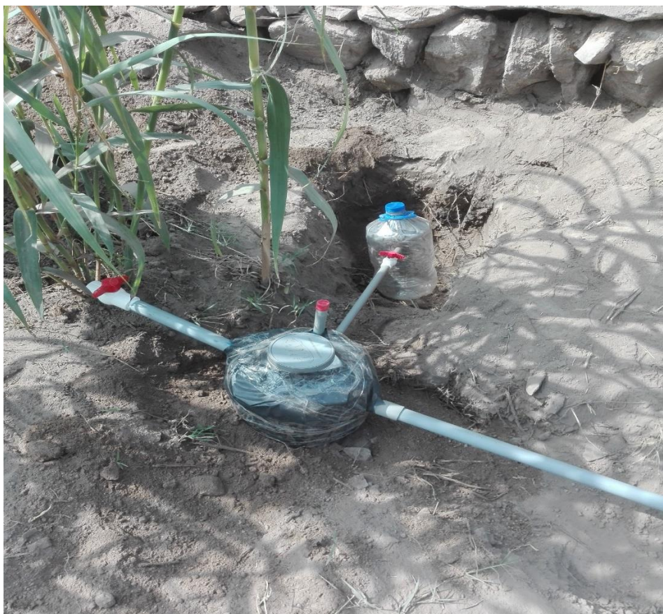
Figura 75. Instalación del biodigestor
