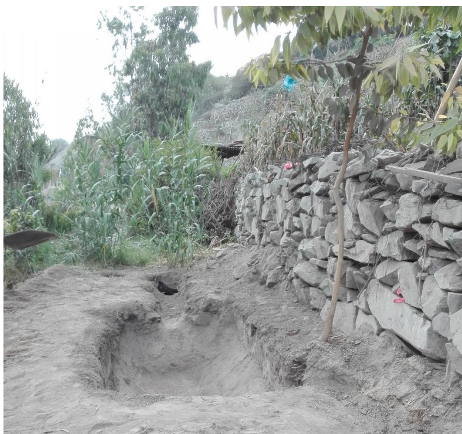
Figura 66. Excavación terminada del sistema de tratamiento mediante HAFSSH
