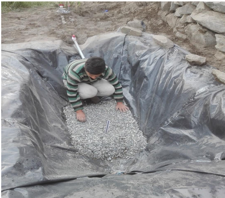
Figura 69. Colocación del lecho filtrante con grava fina
