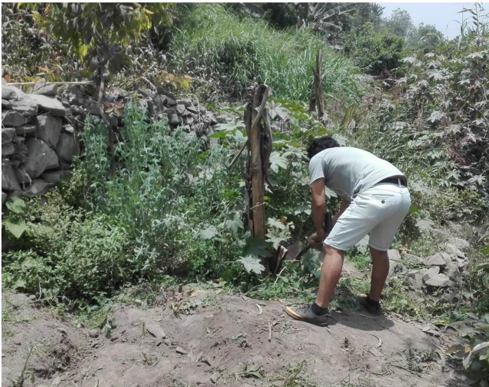
Figura 63. Limpieza del terreno
