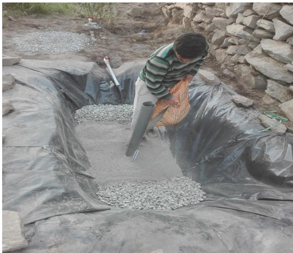
Figura 71. Llenado del lecho filtrante con arena gruesa
