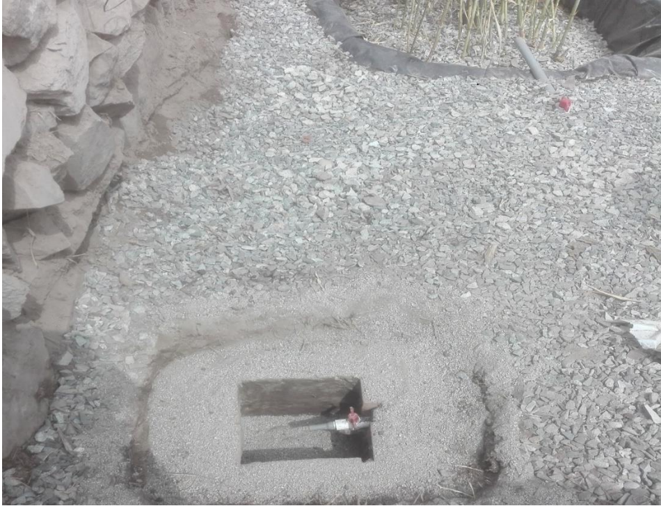
Figura 76. Instalación de la cámara de lodos
