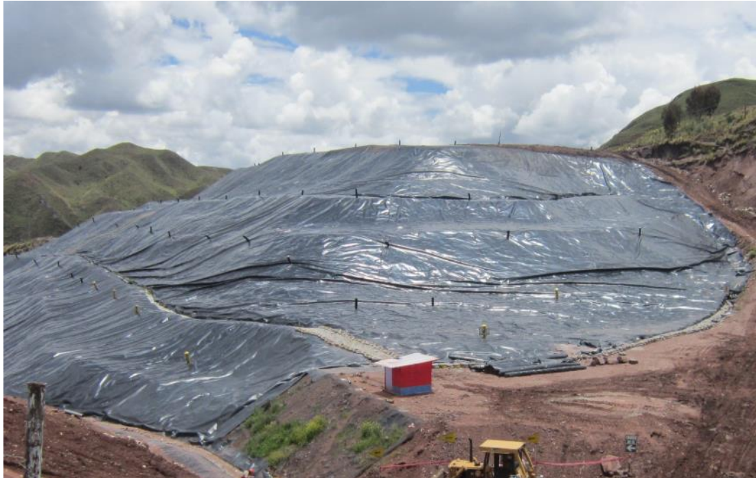
Figura 1. Vista panorámica del botadero de Jaquira
