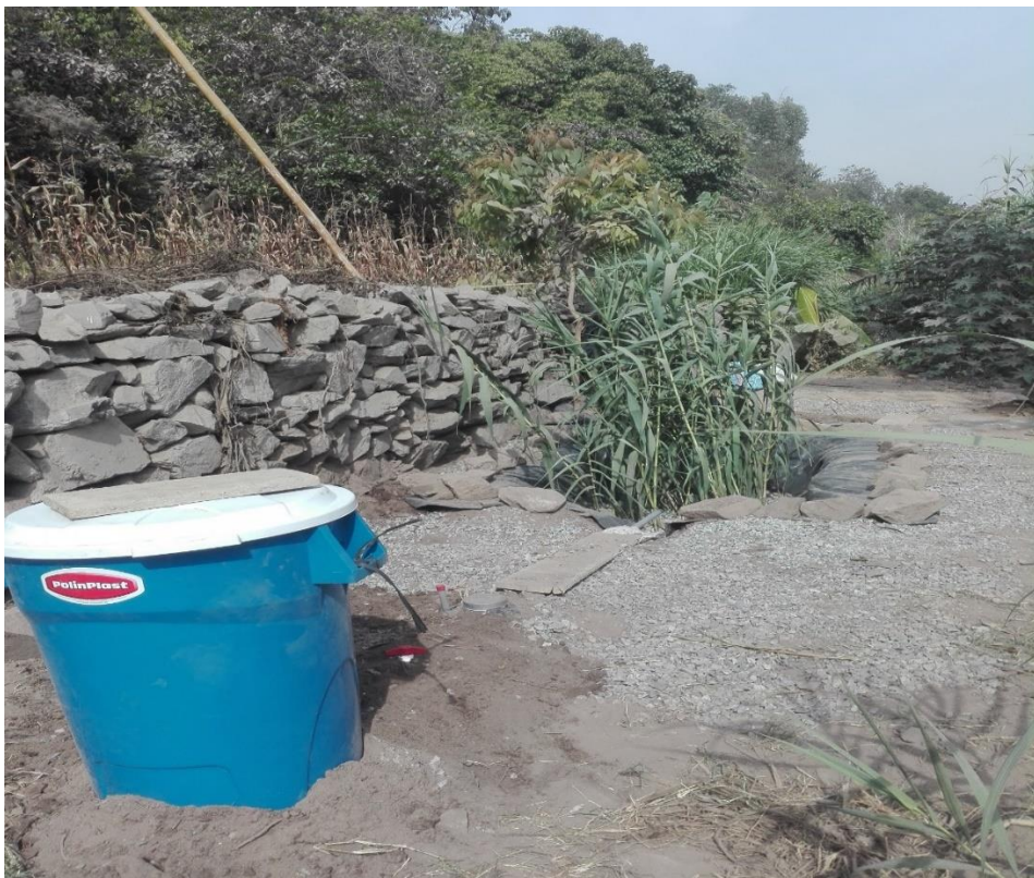
Figura 85. Puesta en marcha del sistema de tratamiento con lixiviado diluido en agua residual
