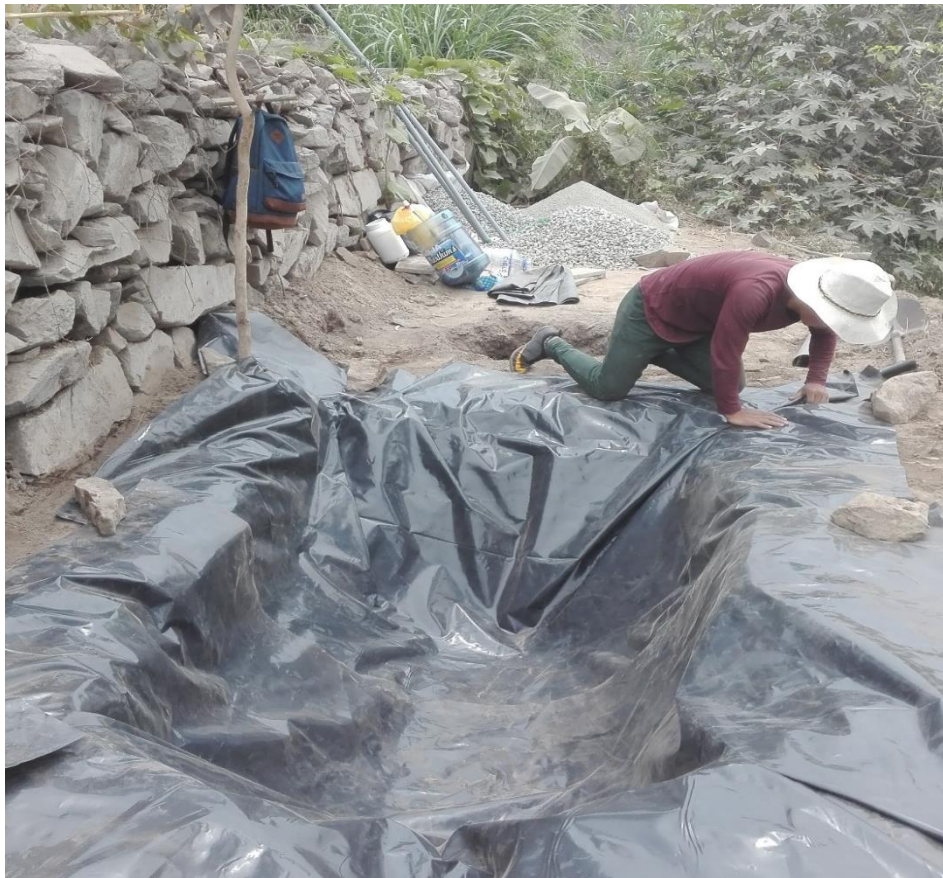
Figura 67. Revestimiento del HA con geomembrana
