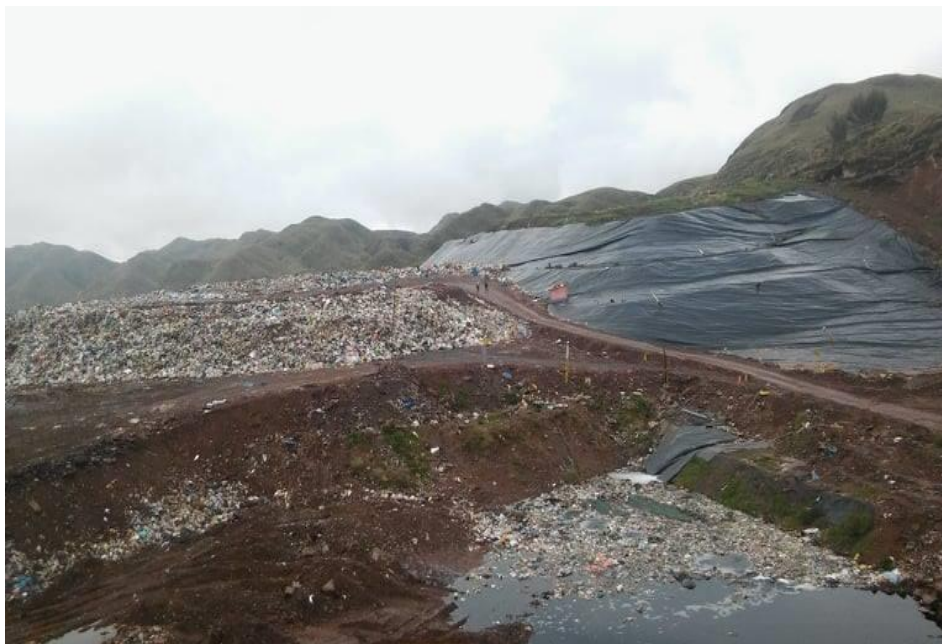
Figura 103. Manejo inadecuado del lixiviado en el botadero Jaquira
