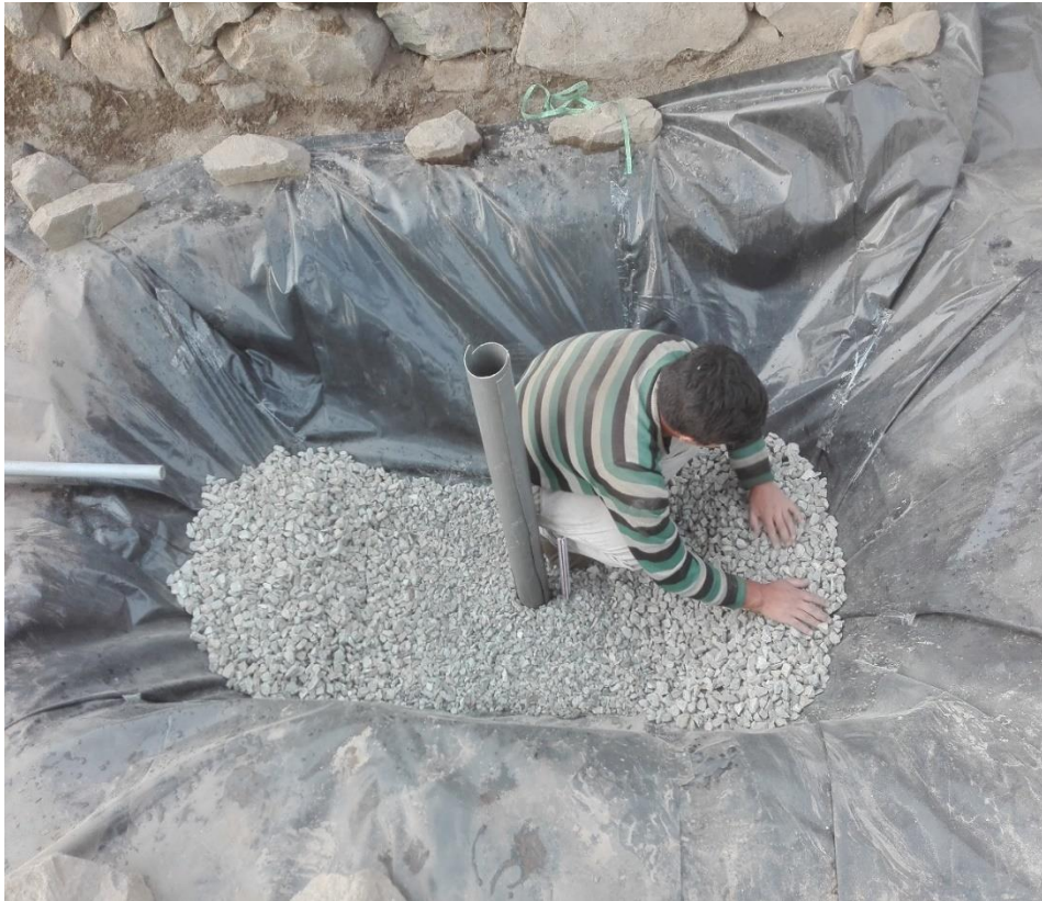
Figura 70. Colocación grava media la zona de entrada y salida
