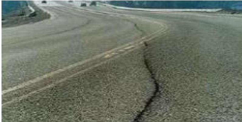
Figura 12. Grietas longitudinales y transversales (No PCC) de baja severidad. Fuente: Corros et al. (2009)
