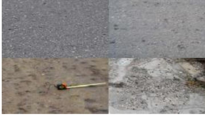
Figura 21. Desprendimiento de agregados. Fuente: INVÍAS (2007)
