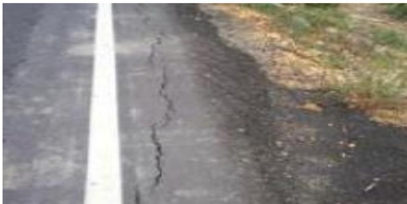
*Figura 9. Grieta de borde de baja severidad. Fuente: Corros, Urbaez y Corredor. (2009)*
