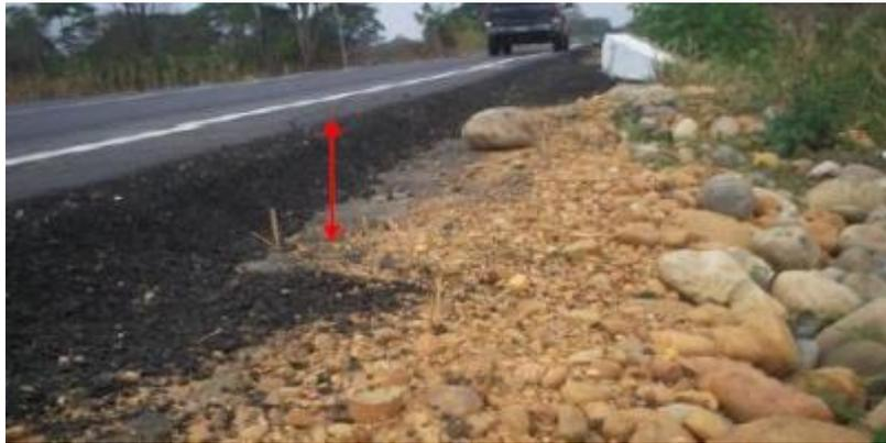
Figura 11. Desnivel carril. Fuente: Corros et al. (2009)
