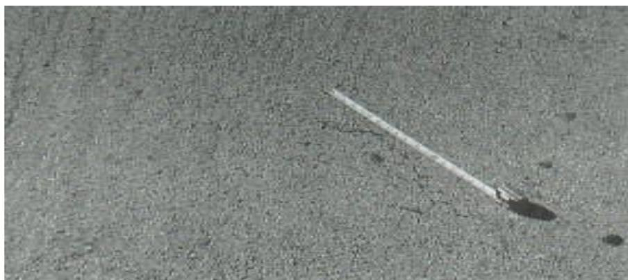
Figura 19. Grieta parabólica baja severidad. Fuente: Vásquez (2002)
