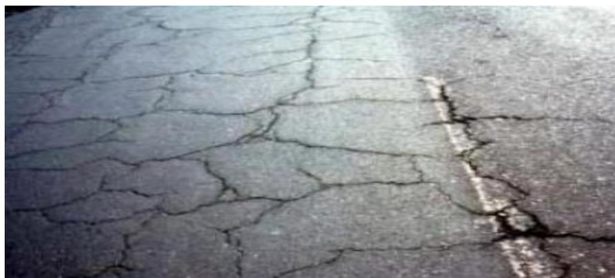
*Figura 5. Grietas en bloque de alta severidad. Fuente: INVIAS (2007)*
