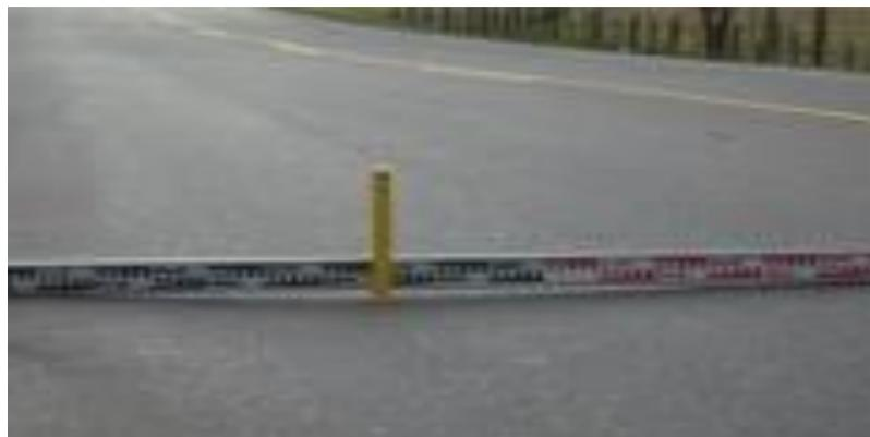
Figura 17. Ahuellamiento baja severidad. Fuente: Vásquez (2002).
