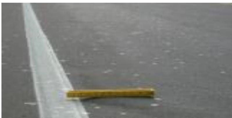
Figura 18. Desplazamiento baja severidad. Fuente: Vásquez (2002).
