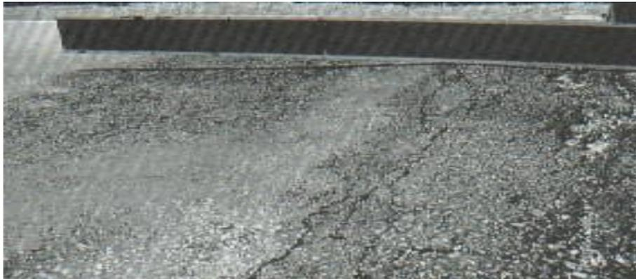
Figura 6. Abultamientos y hundimientos de alta severidad. Fuente: Vásquez (2002)
