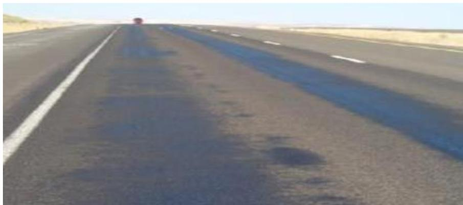
Figura 4. Exudación en baja severidad. Fuente: Invias (2007)
