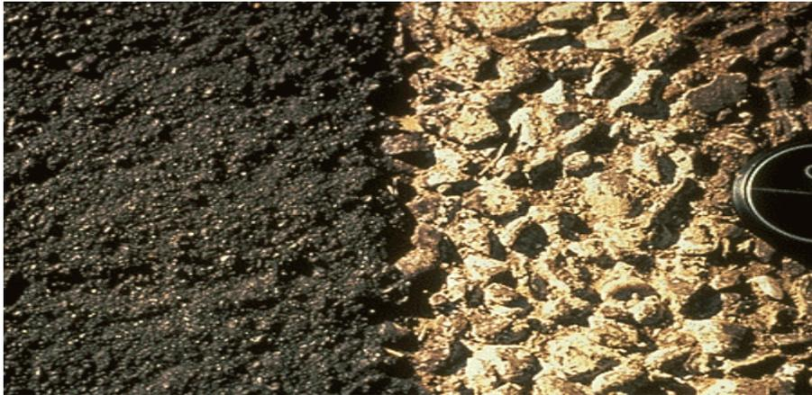
*Figura 26.* Aplicación de Slurry Seal en pavimento viejo. Fuente: PIT (2016)
