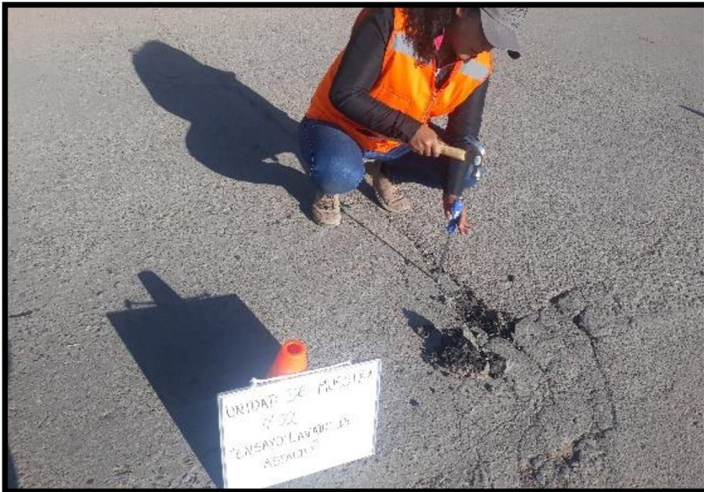
Fotografía 5. Extracción de carpeta asfáltica para el ensayo de lavado de asfalto.
