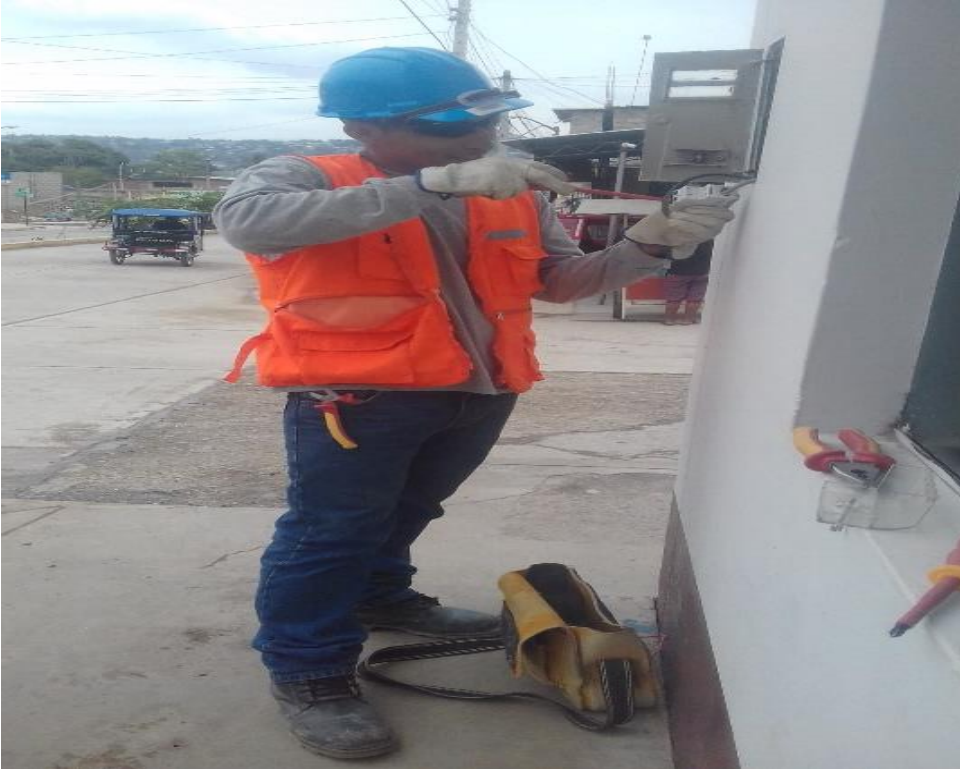
Anexo 4.1. Reparación de medidores en área comercial
