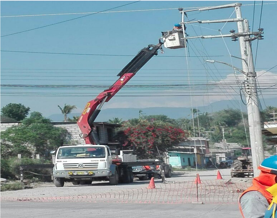
Anexo 4.5. Tarea en el área de seguridad y maniobras
