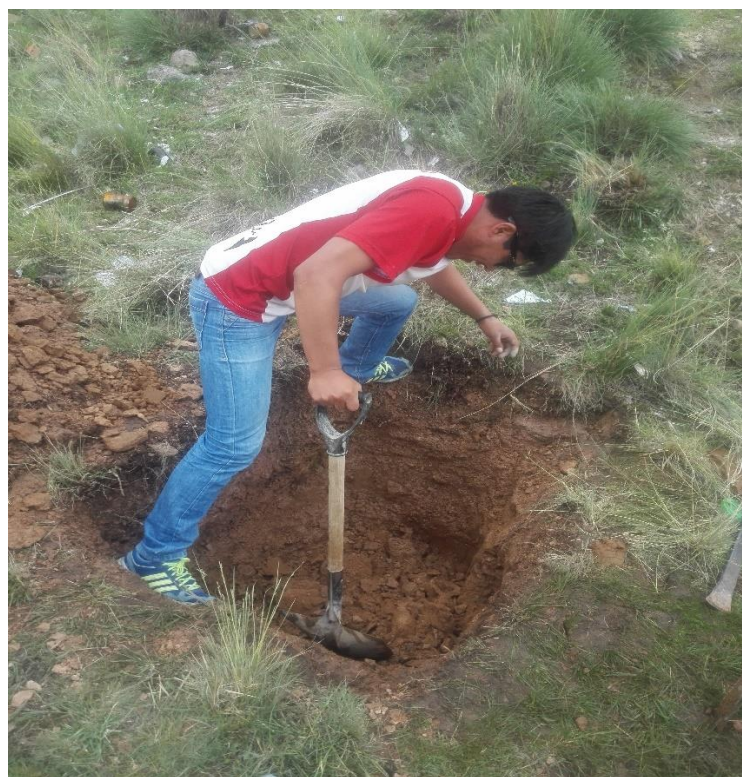
Figura 45: Realizando limpieza de la calicata
