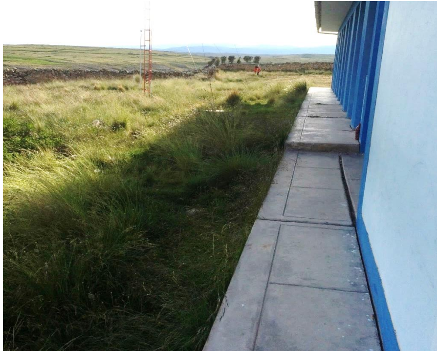
Figura 60: Levantando aulas existentes
