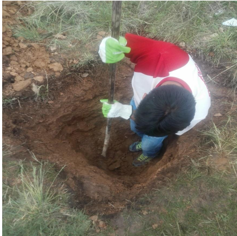
Figura 46: Perfilando la calicata
