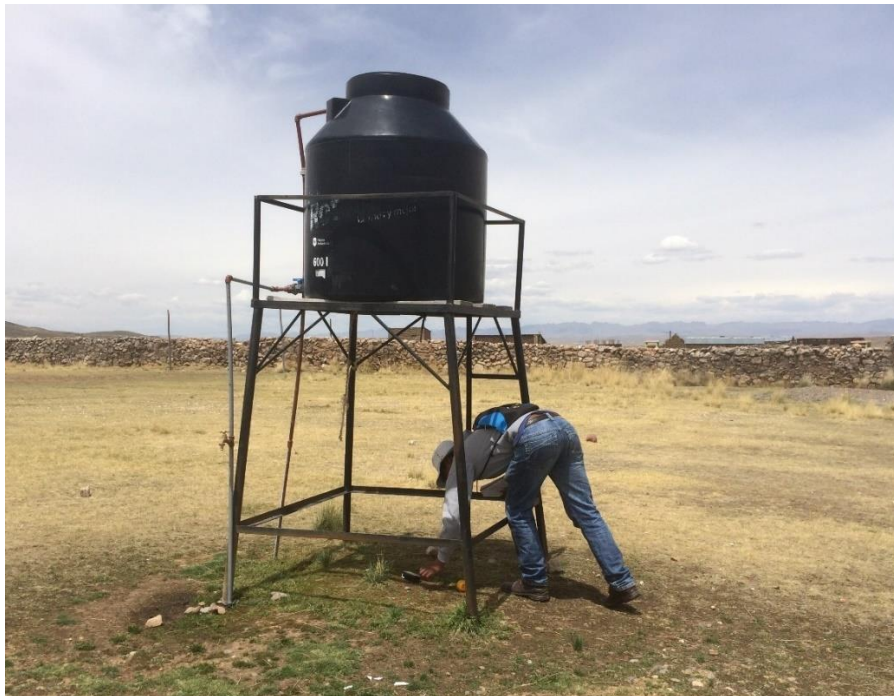
Figura 61: Capturando ubicación de estructuras existentes
