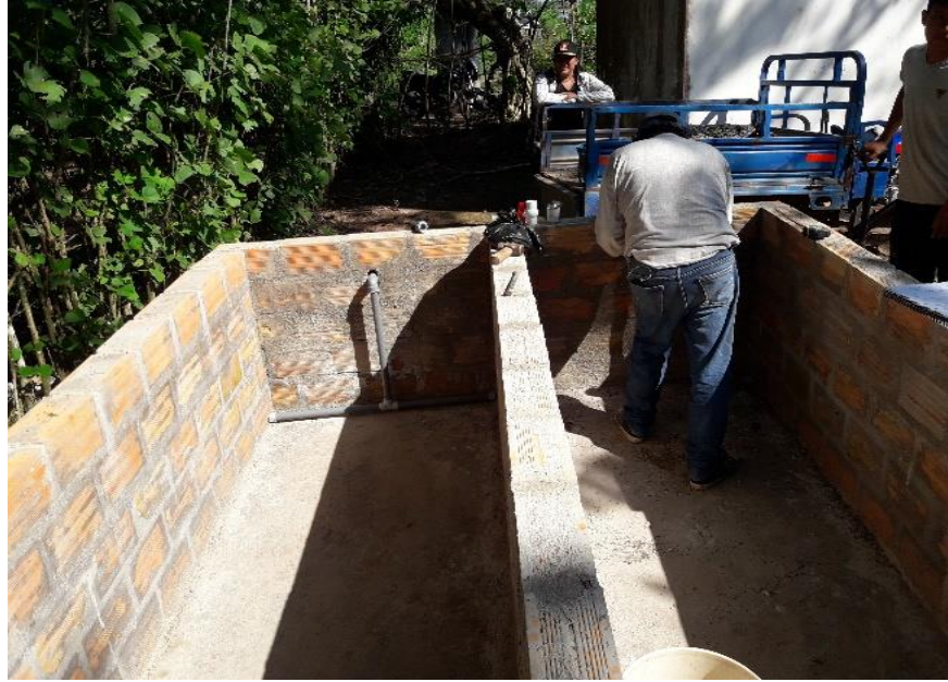
Anexo 20.3 Instalación de tuberías de los humedales
