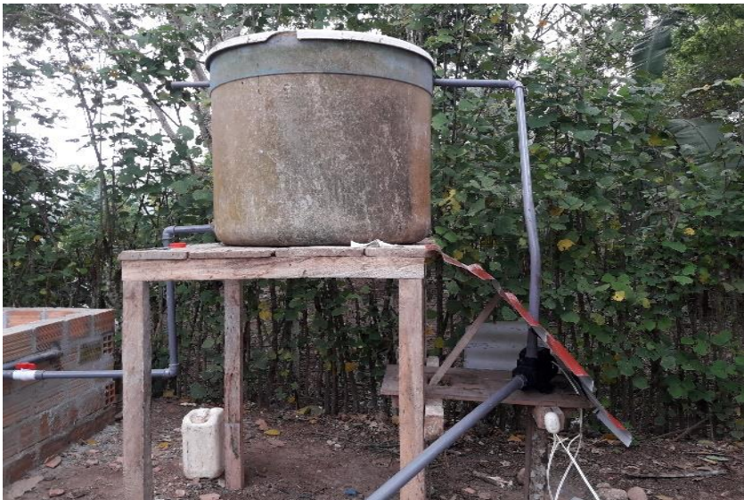
Anexo 20.6 Instalación del motor y radar.
