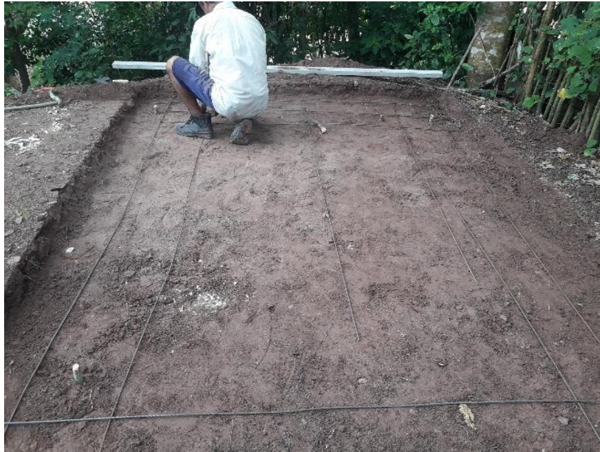
Anexo 20.1 Colocación de fierro en la base del humedal
