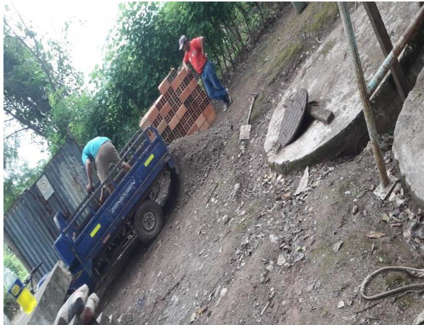
Anexo 20.2 Materiales para iniciar la construcción
