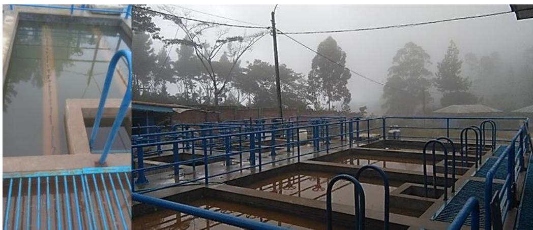
En la Figura 97 se muestra las unidades de decantación tratando un agua con alto contenido de turbidez, en la imagen se puede visualizar la deficiencia que presenta la unidad para tratar agua de esa calidad.
