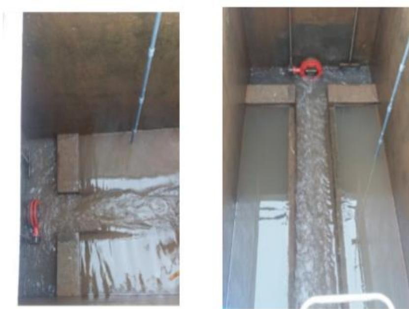
El lavado de filtro que se efectúa es ineficiente, la superficie del filtro posterior al lavado presenta impurezas. Esto no es debido a la falta de expansión, ya que esta es excesiva, se debe al ahogamiento del canal de lavado.
