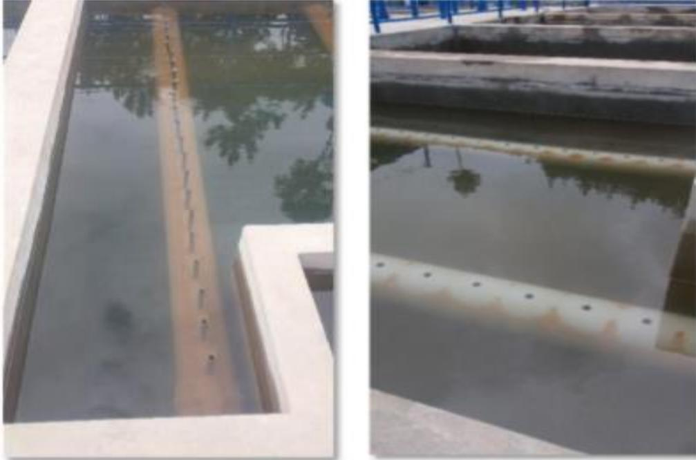
*Nota:* La vista fotográfica izquierda muestra los tubos de 25cm de alto colocados en los orificios de las tuberías de recolección, al lado derecho se observa las tuberías de recolección de agua decantada sin los tubos de PVC en los orificios.
