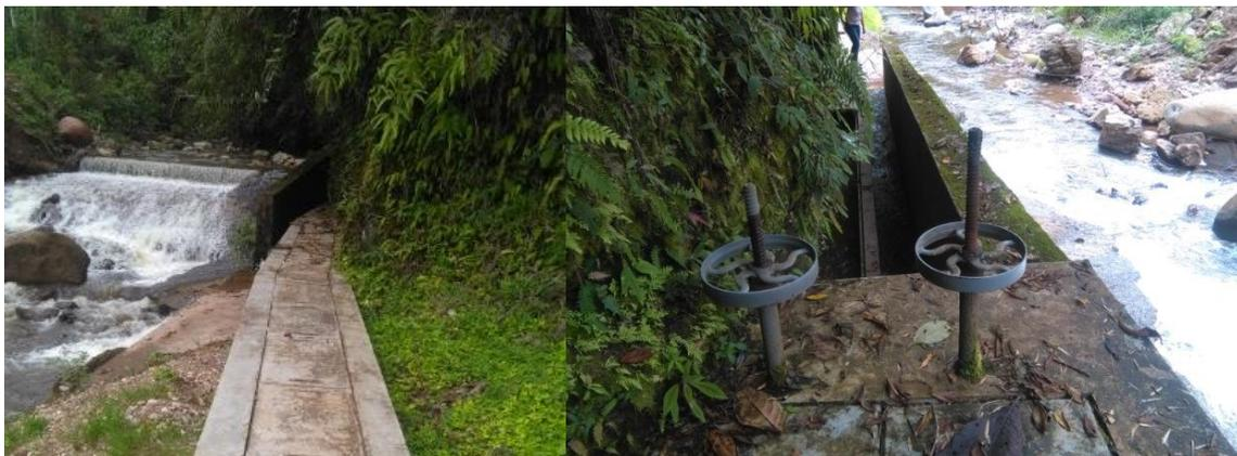
La Figura 23 muestra el canal de conducción de agua para el tratamiento y las válvulas de compuerta que se controlan manualmente para regular el caudal de agua que será transportado hacia la PTAP.
