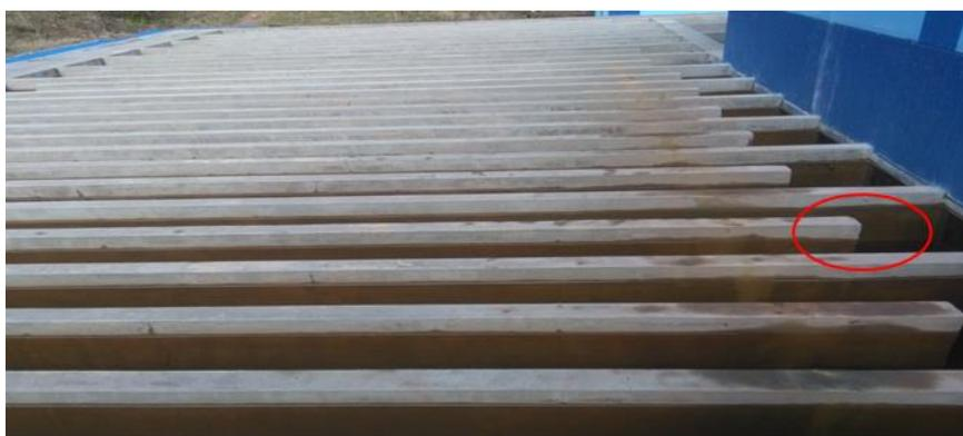
En la vista fotográfica de la Figura 94 se observa la unidad de floculadores con un nivel de turbidez muy elevado y en la figura 95 se observa que las pantallas presentan esquinas que generan pequeños remolinos turbulentos que rompen los flocs formados o en formación.
