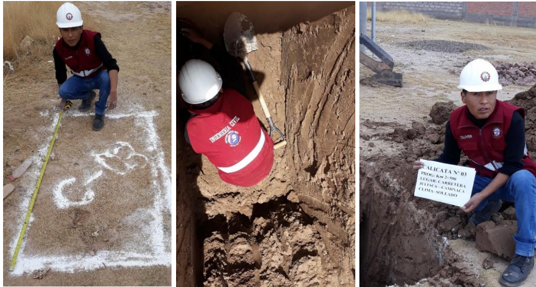
Figura 21. Vista de C - 03 de la carretera Juliaca - Caminaca (Elaboración propia)
