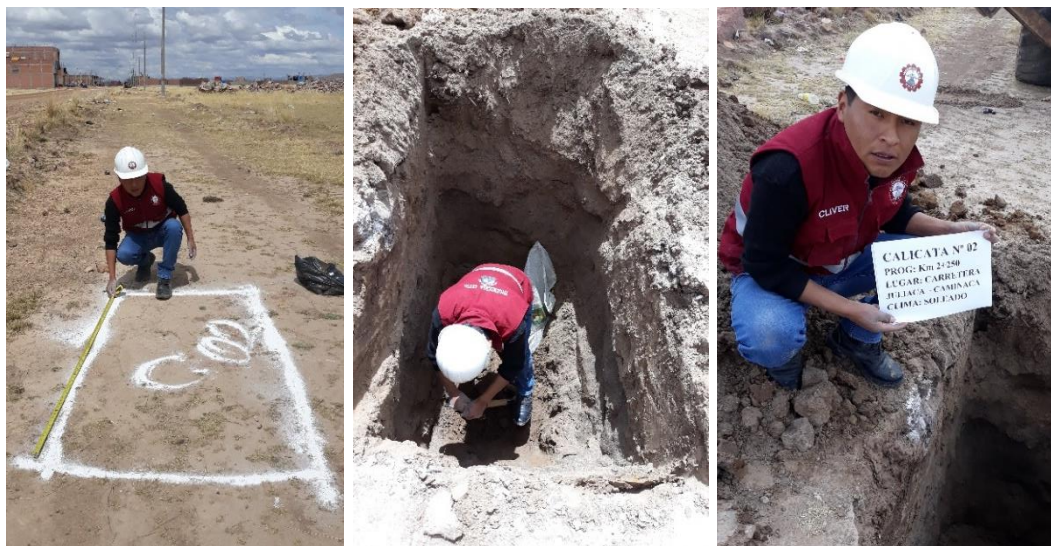
Figura 20. Vista de C - 02 de la carretera Juliaca - Caminaca (Elaboración propia)
