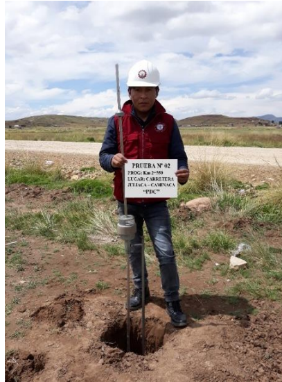
Figura 26. Ensayo de PDC in – situ (Elaboración propia)
