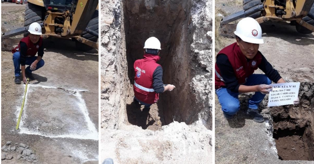
Figura 19. Vista de C - 01 de la carretera Juliaca - Caminaca (Elaboración propia)
