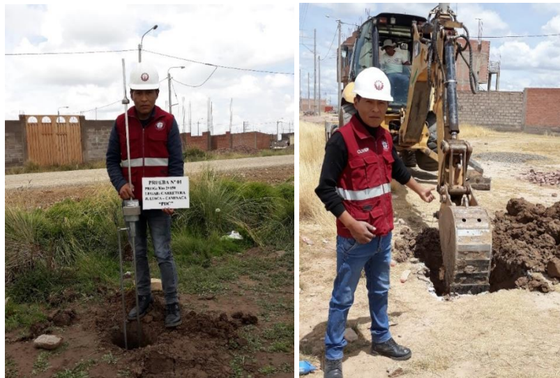
Figura 16. Ensayo de PDC y Excavación de Calicatas (Elaboración propia)
