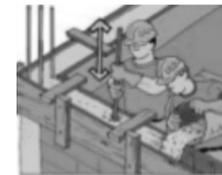
Amar vigas, estribadas con alambre y encofrar para el vaceado, luego desencofrar.
