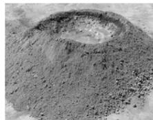
Elaborar mezcla con 1 de cemento, 4 de arena y 1 de agua.
