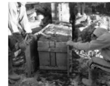
Encofrar y desencofrar para hacer sobrecimiento, y rellenar con barro.
