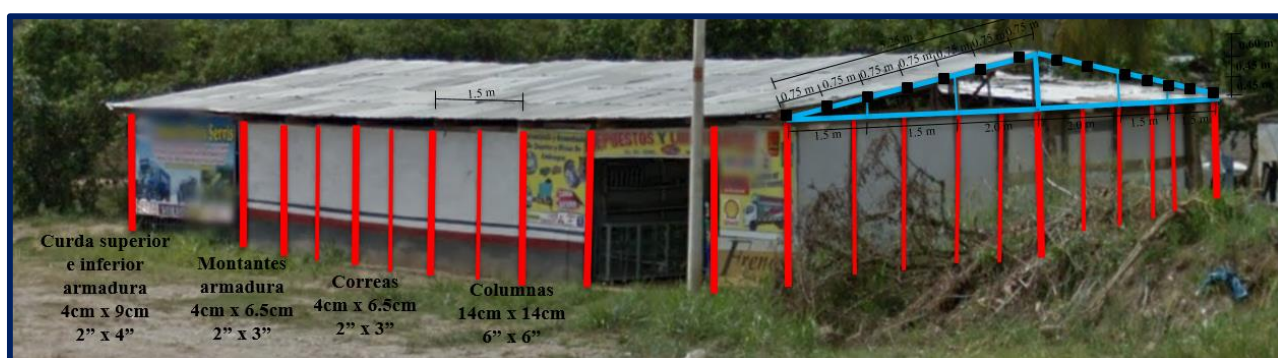
Figura 13. Estructura convencional en la zona. Fuente: Propia.
