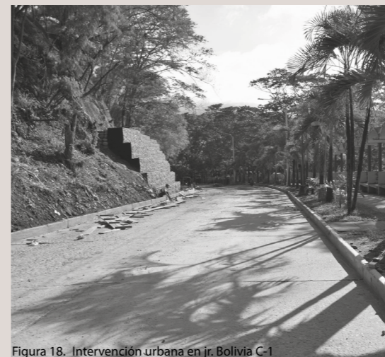
Figura 18. Intervención urbana en Jr. Bolivia C-1 Fuente: Municipalidad provincial de San Martín (2017)
