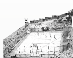
12 Losa quinta etapa
