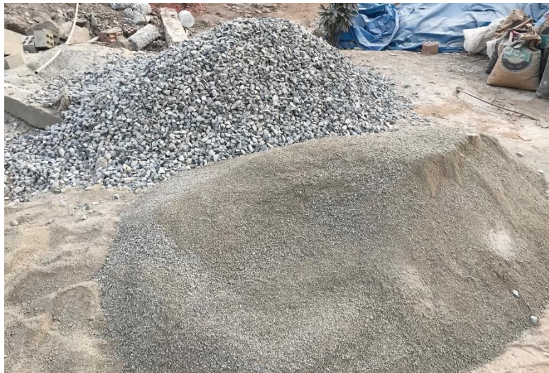
Imagen 8 Acopio de agregados grueso y fino.
