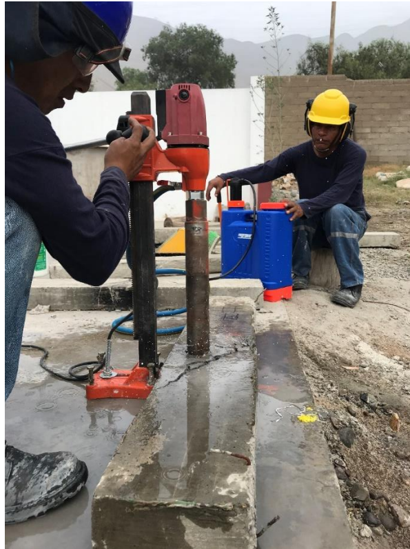
Imagen 28 Perforación y extracción de vástago de concreto.
