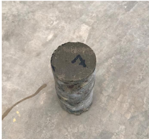
Imagen 29 Vástago de concreto extraído de la viga #7.
