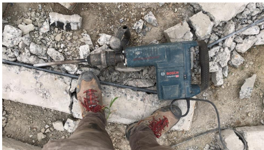
Imagen 34 Extracción de barra de refuerzo con roto martillo Boch.
