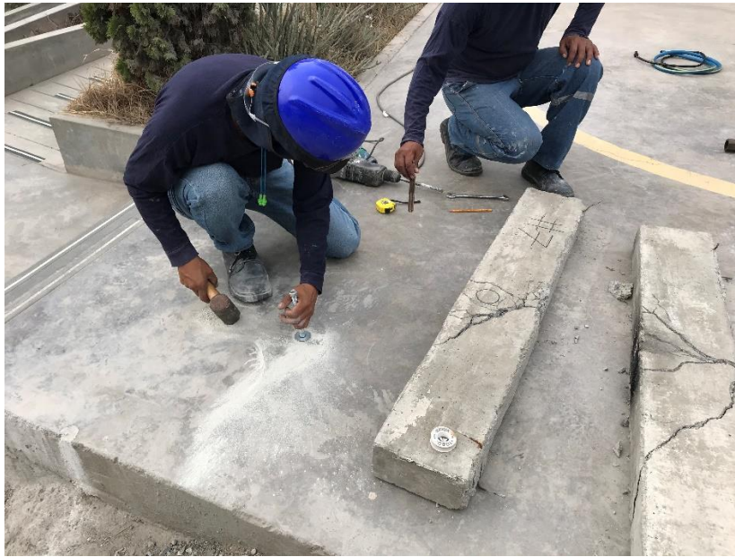
Imagen 24 Perforación y anclaje de la perforadora de diamantina.
