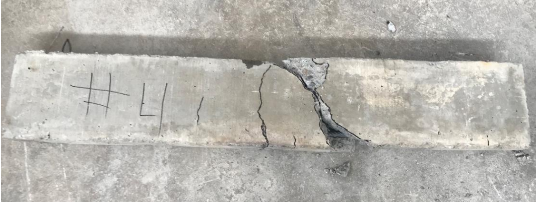
Imagen 55 Falla de la muestra # 4.
