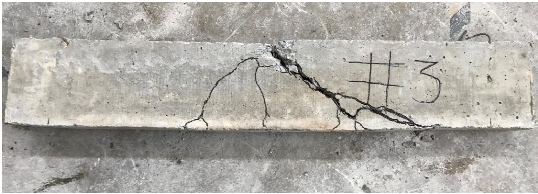
Imagen 56 Falla de la muestra # 3.
