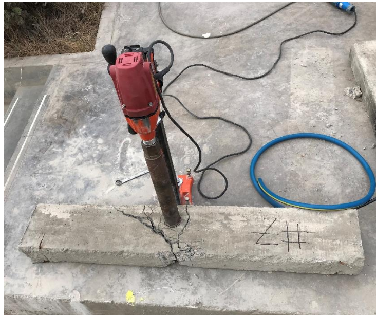
Imagen 27 Equipo de perforación de diamantina sobre punto de extracción de vástago de concreto.
