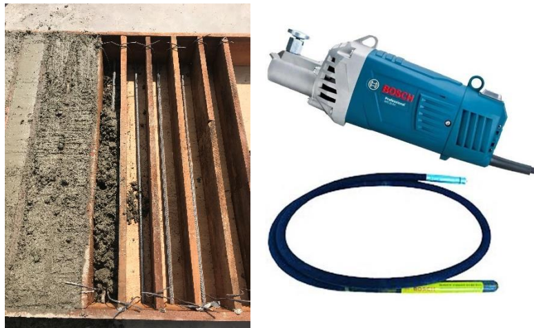
Imagen 12 Encofrado y vibradora de concreto Boch.
