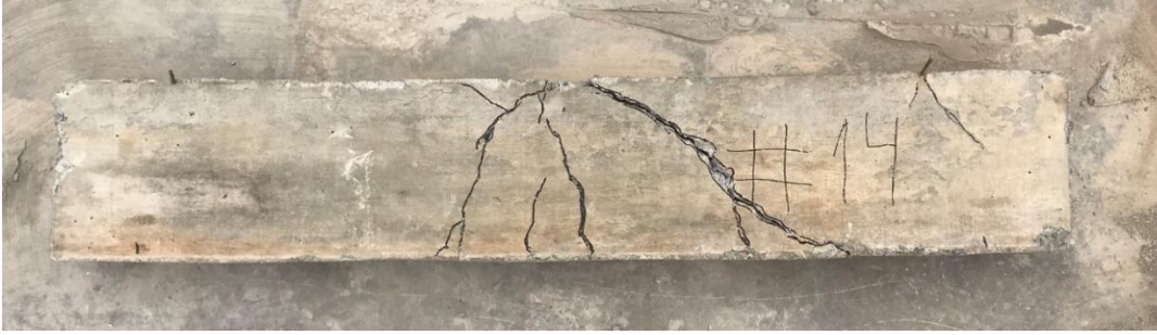
Imagen 46 Falla de la muestra #14.
