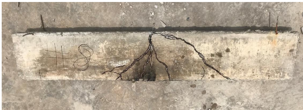
Imagen 51 Falla de la muestra # 8.
