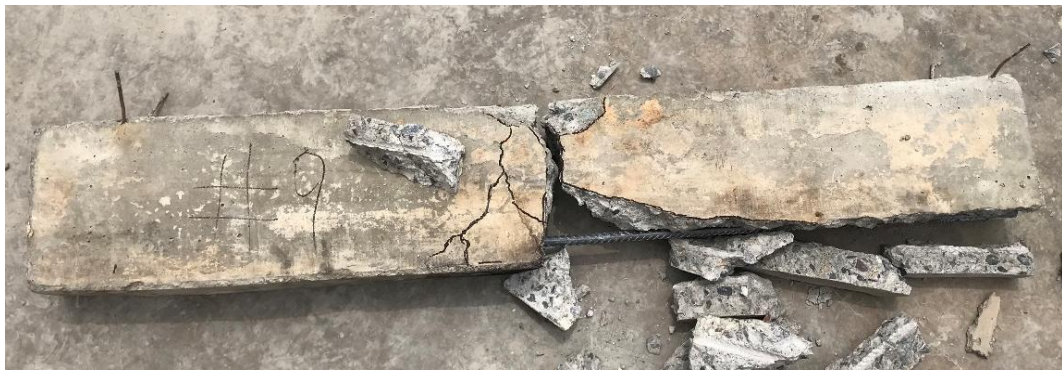
Imagen 50 Falla de la muestra # 09.
