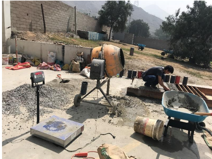
Imagen 11 Materiales y equipos para el vaciado del concreto.
