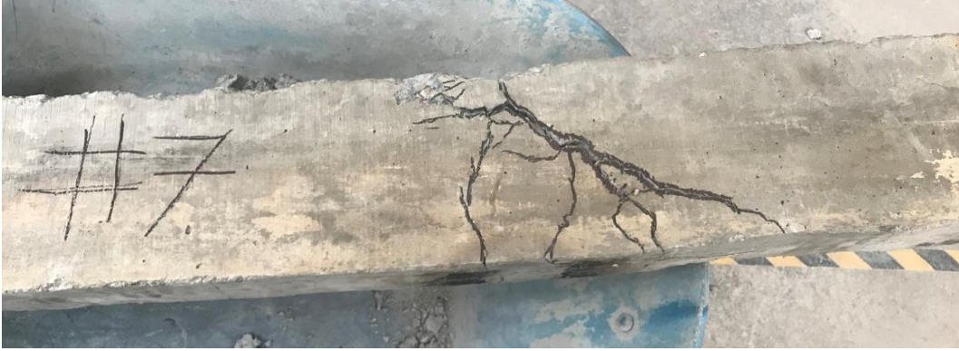
Imagen 52 Falla de la muestra # 7.
