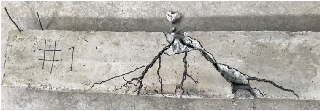
Imagen 58 Falla de la muestra # 1.
