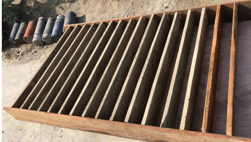
Imagen 9 Módulo de encofrado de vigas.
