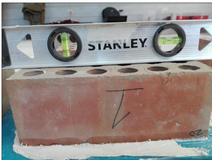
Figura 27. Controlando la nivelación del ladrillo
