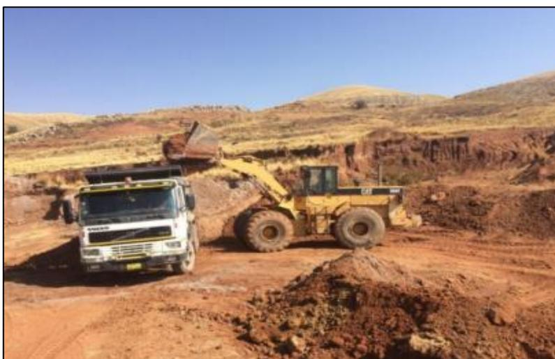
*Figura 1.* Extracción y carguío de la arcilla.
