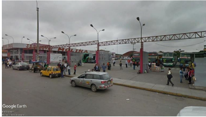
Figura 58. Exteriores del Terminal de Yerbateros. Fuente: Google Earth, 2020.
