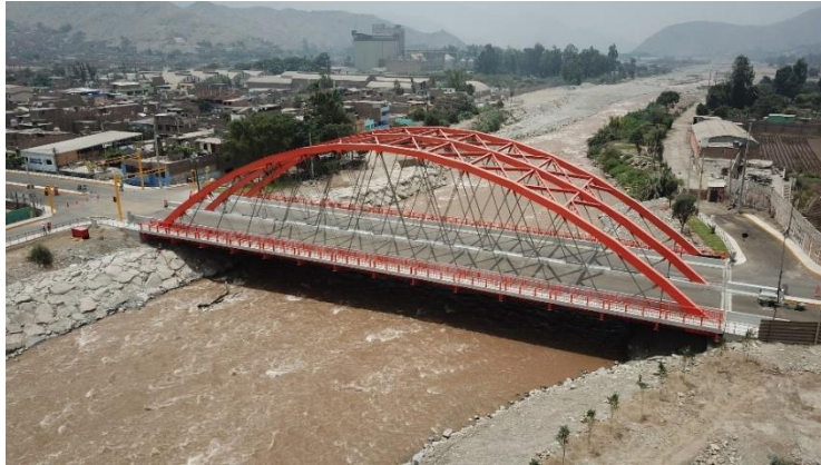
Figura 10. Pte. Ñaña. Estructura nueva inaugurada el 2018. Fuente: Revista Perú Construye, 2018.
