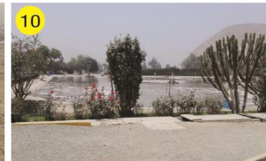
10 Planta de Tratamiento de Aguas residuales. Fuente: Google photos 2019
