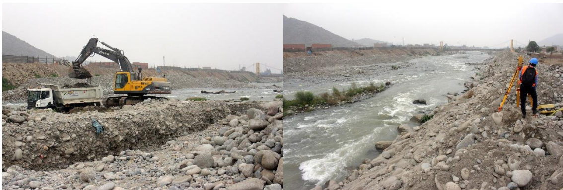
Figura 40. (Izquierda) Trabajos de limpieza del caudal del río Rímac. Figura 41. (Derecha) Trabajos para el levantamiento de la defensa ribereña. Fuente: Agro Rural, 2017.
