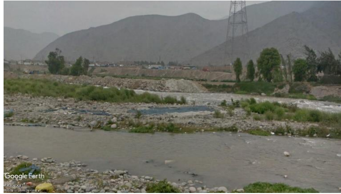
Figura 42. Bordes del río Rímac han sido rellenados con desmorte, logrando invadir el cauce natural del río. Fuente: Google Earth, 2020.
