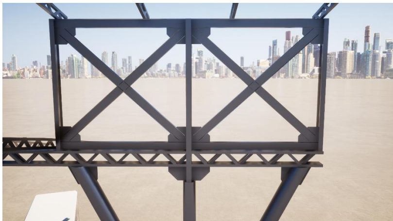
Figura 141. Estructura que sostiene los arcos de segundo tipo. Se apoya en la cencha longitudinal. Está conformada por perfiles tipo I. Fuente propia.
