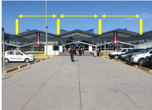
Figura 107. Terrapuerto Trujillo, estructuras de acero permiten grandes luces. Fuente: Terrapuerto Trujillo, 2020.
