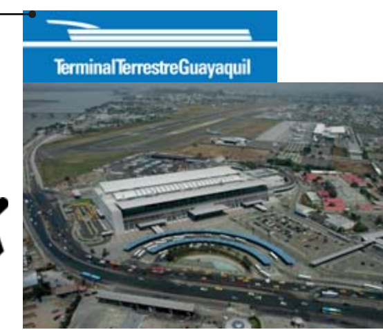
ESTACIÓN METROVÍA RÍO DAULE
