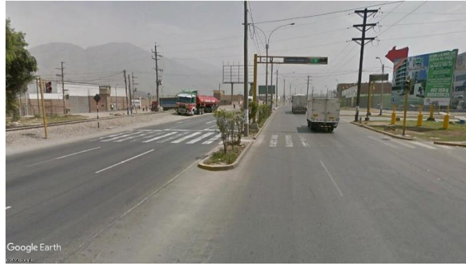
Figura 73. El “Paradero Lavadero” solo cuenta con semafORIZACIÓN y señalización horizontal, a ambos lados no se puede encontrar la infraestructura necesaria para los pasajeros. Fuente: Google Earth, 2020.
