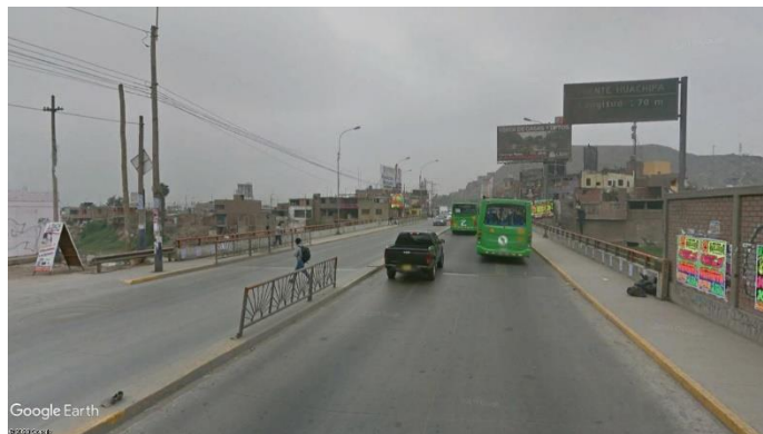
Figura 12. Pte. Huachipa con 4 carriles de tránsito. Fuente: Google Earth, 2020.
