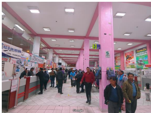
Figura 65. La infraestructura del terminal ha sido edificada mediante el método del sistema aporticado. Fuente: Google Earth, 2020.
