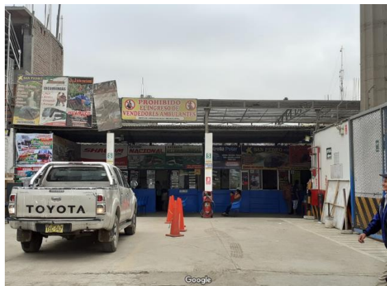
Figura 83. Patio del terminal y cobertura de calamina. Fuente: Google Earth, 2020.
