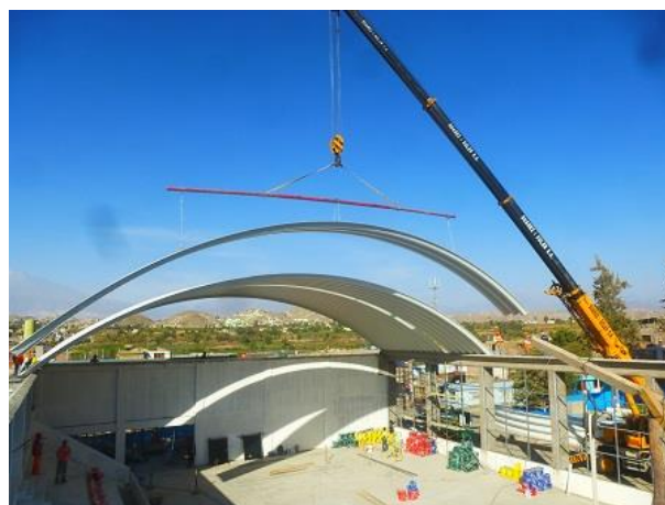
Figura 147. Instalación de aluzinc con medidas especiales, según proyecto. Fuente: Aceros del Perú, 2020.
