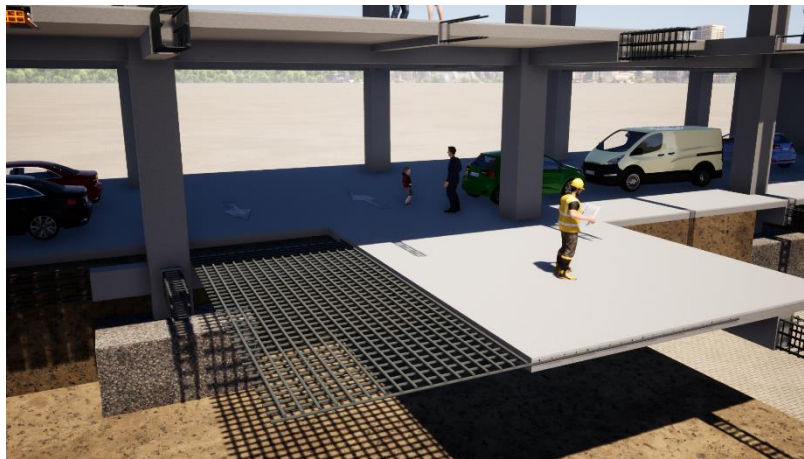
Figura 134. Enmallado realizado en la losa del sótano. Fuente propia.
