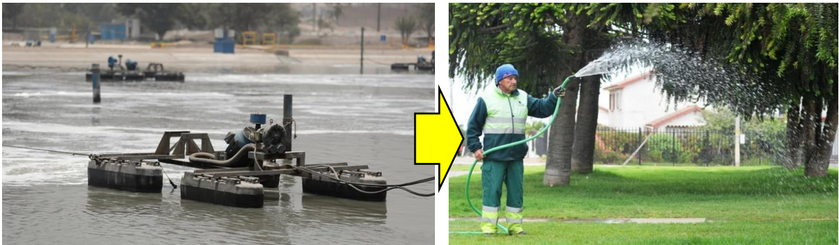
Figura 109. (Izquierda) Aguas tratadas de la PTAR Carapongo servirán para regar áreas verdes del terminal terrestre. Fuente: MVCS, 2018.
