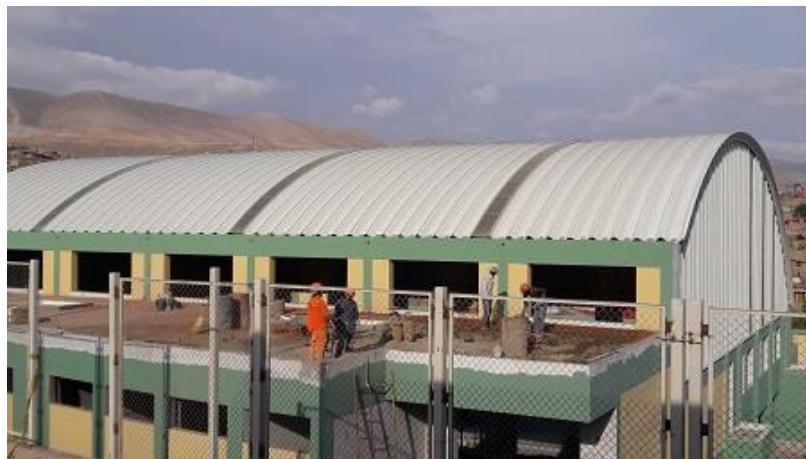
Figura 146. Cobertura de aluzinc instalada en polideportivo. Fuente: Aceros del Perú, 2020.
