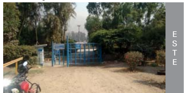
PTAR Carapongo Fuente: Google Earth, 2020.
