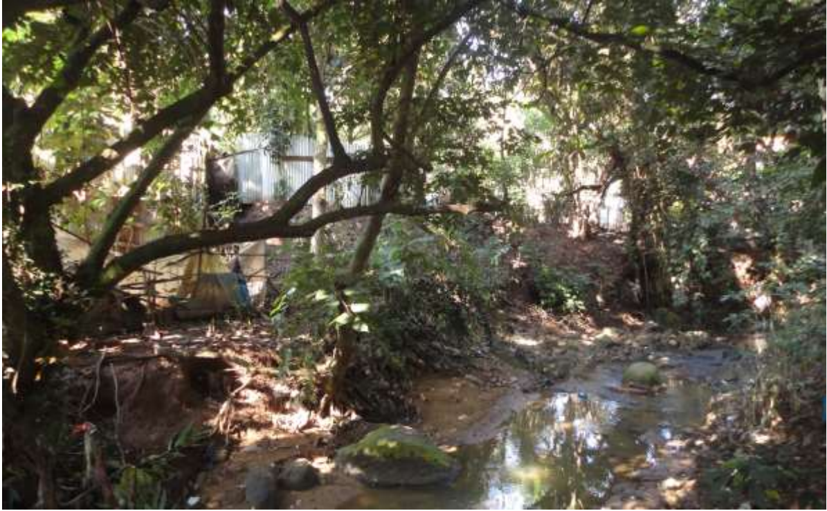
Ilustración 8: Construcción de viviendas con material de calamina en la faja marginal de la quebrada– Flor de la Molina.
