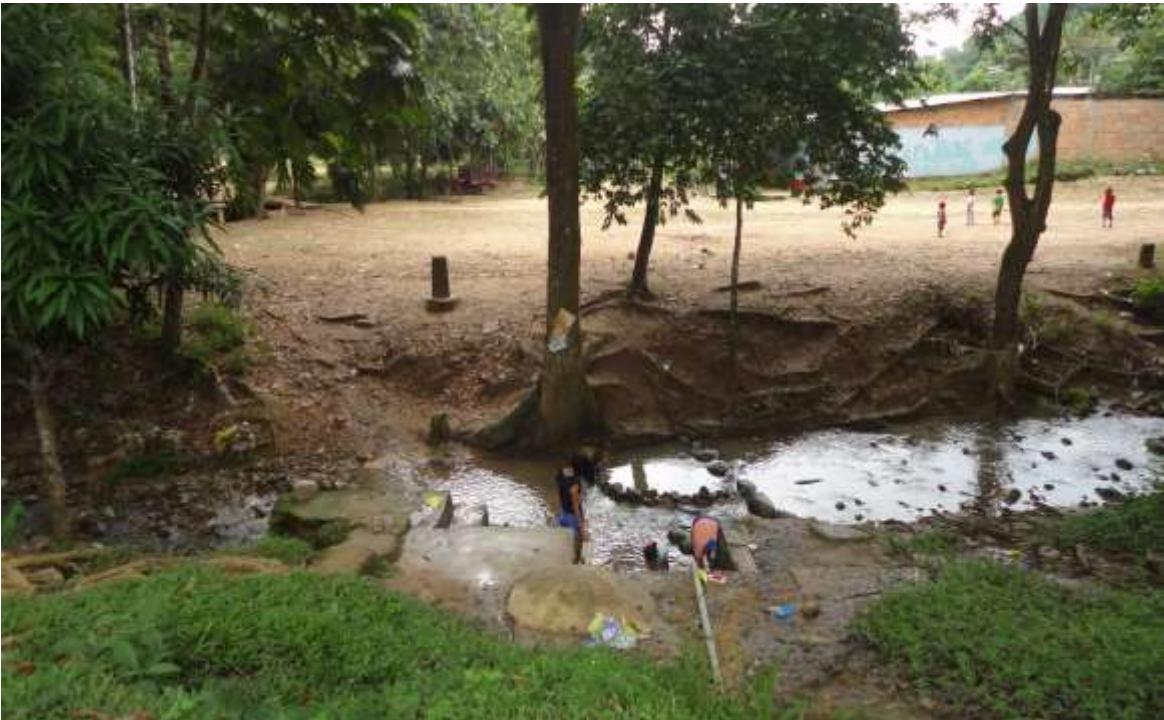
Ilustración 2: Desborde de la quebrada, altura campo deportivo – Flor de la Molina.
