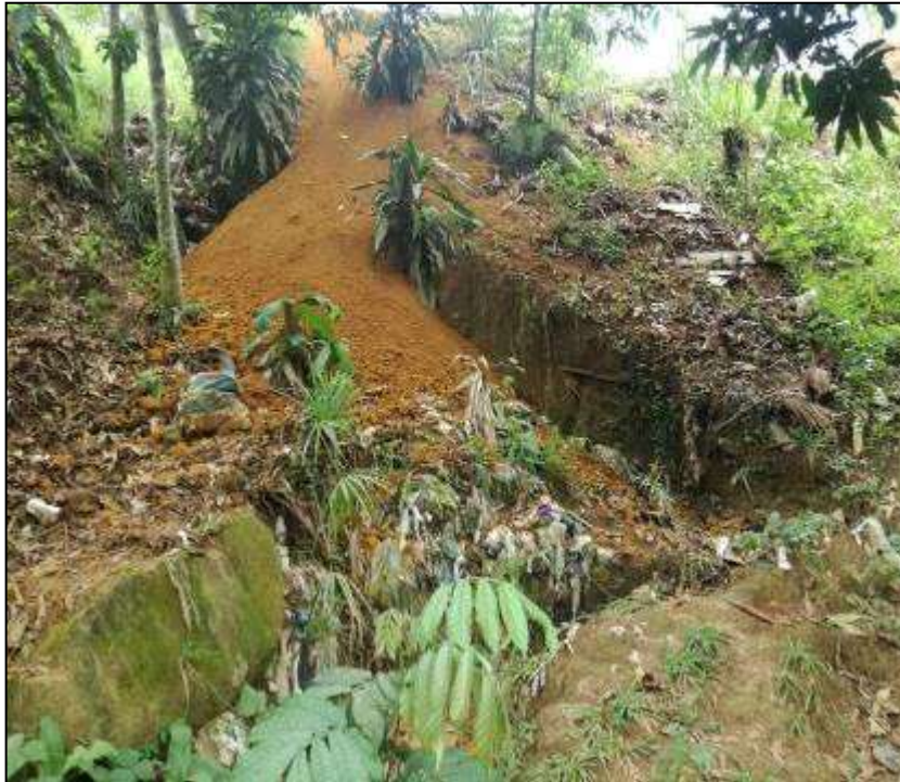
Foto 22: Disposición de material de construcción.
