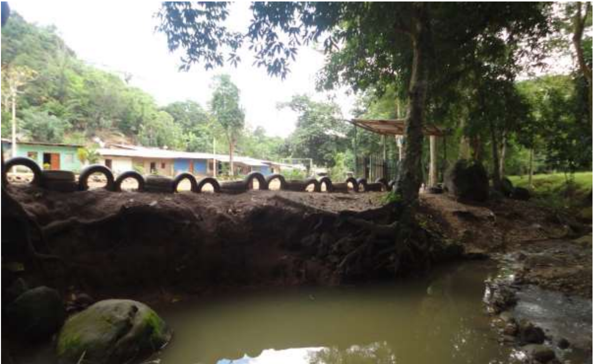
Ilustración 17: Construcción de viviendas en la faja de la quebrada.
