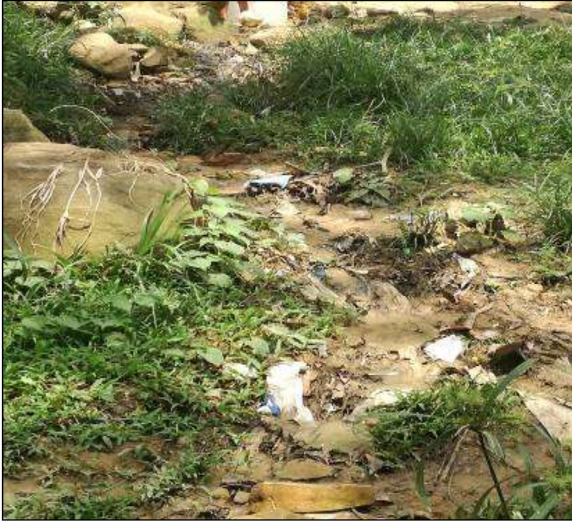
Foto 21: Vertimiento de aguas residuales.
