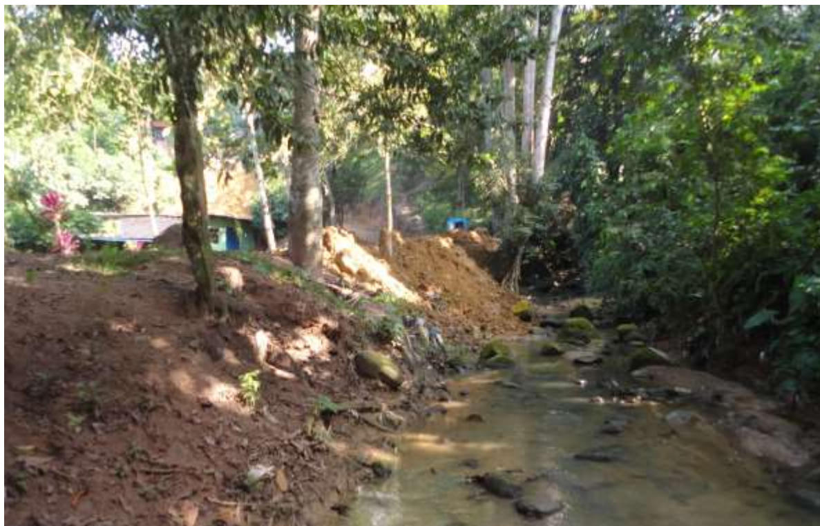
Ilustración 5: Disposición inadecuada de material de construcción– Flor de la Molina.
