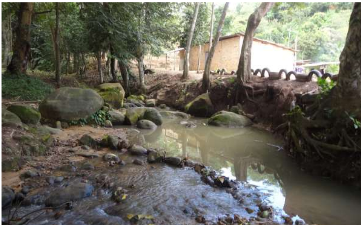
Ilustración 15: Desborde de la quebrada, construcción de viviendas en la faja marginal.
