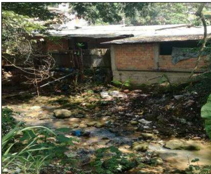
Foto 6: Invasión en la faja marginal de la quebrada.
