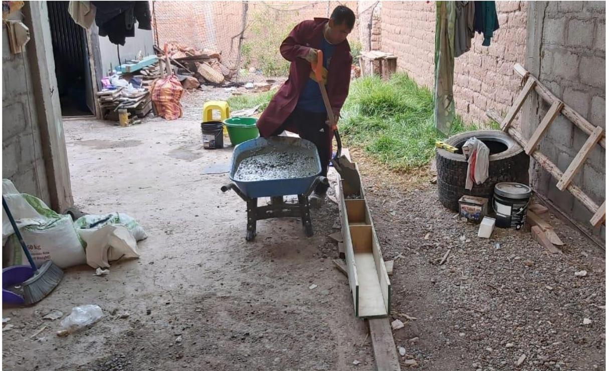
**Fotografía 13.** Se observa el vaciado de concreto en el encofrado para las vigas.
