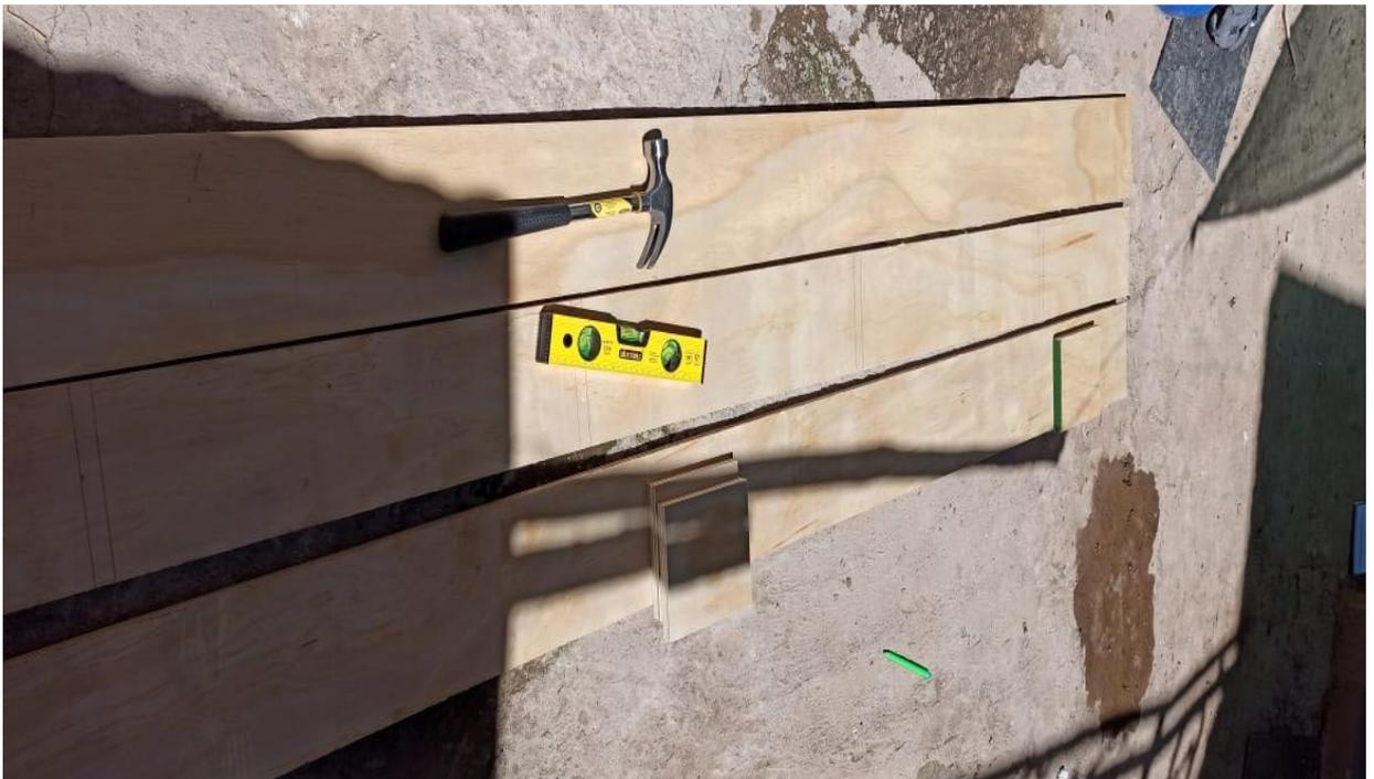
**Fotografía 08.** Se observa los materiales usados para el encofrado de las vigas.
