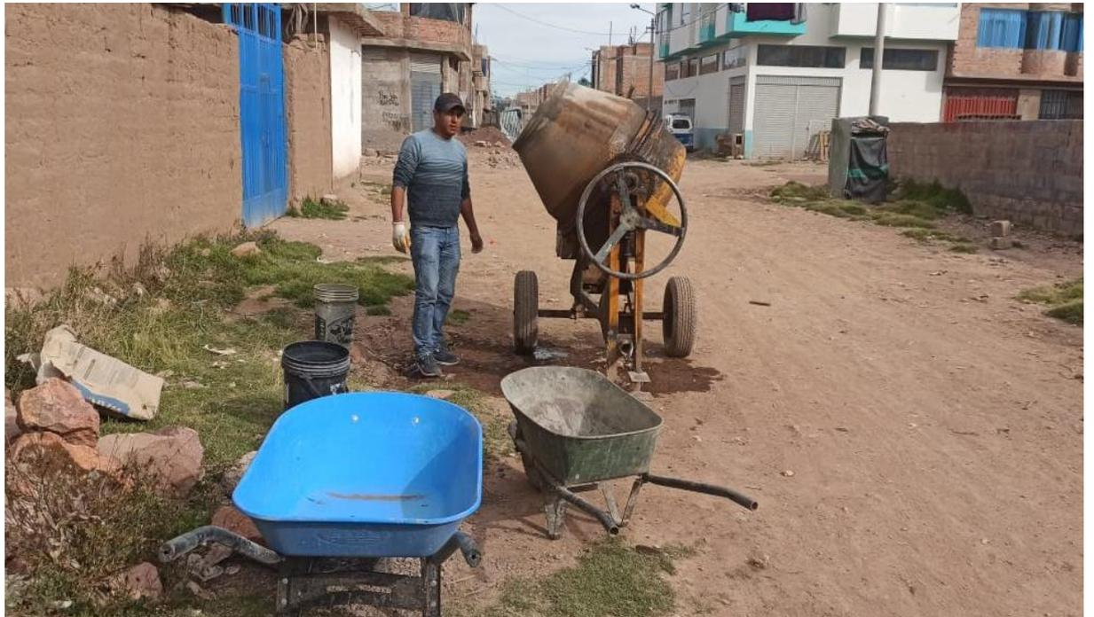
**Fotografía 10.** Elaboración de concreto, con uso de mezcladora tipo trompo.
