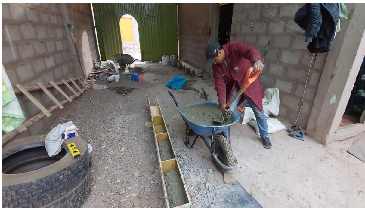
**Fotografía 12.** Colocación del concreto en los moldes de viga.
