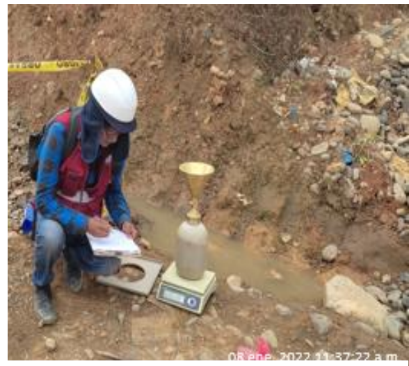
Figura 4. Ensayo de cono de arena in situ
