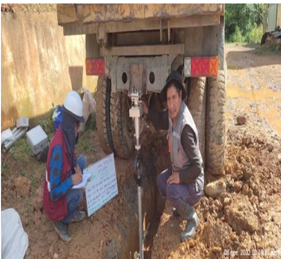
Figura 3. Ensayo de CBR in situ capacidad de 10KN
