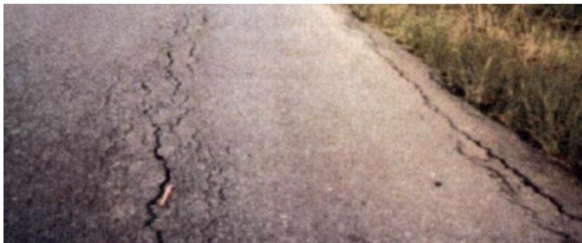
*Figura 14: Grietas longitudinales y transversales. Fuente: Ministerio de Transportes y Comunicaciones. (2014)*
