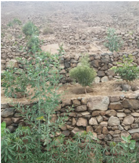
Figura 22. Drenaje de agua en andenería por medio del muro de contención
