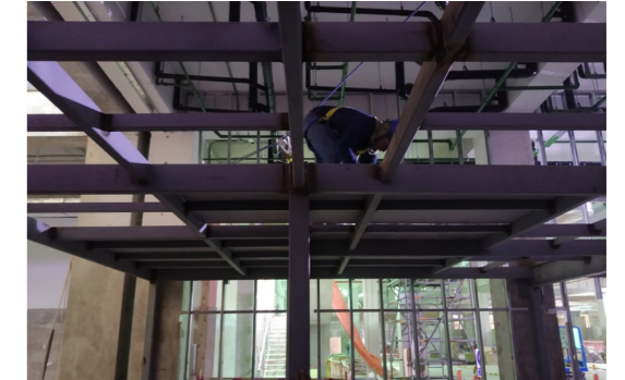
Figura 35: Área de Intervención, Vista de Estructura Metálica - Mezzanine.
