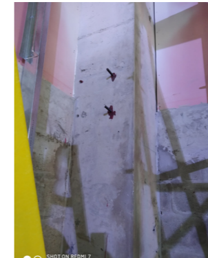
Figura 36: Pernos de Anclaje Con HILTI epóxico.
