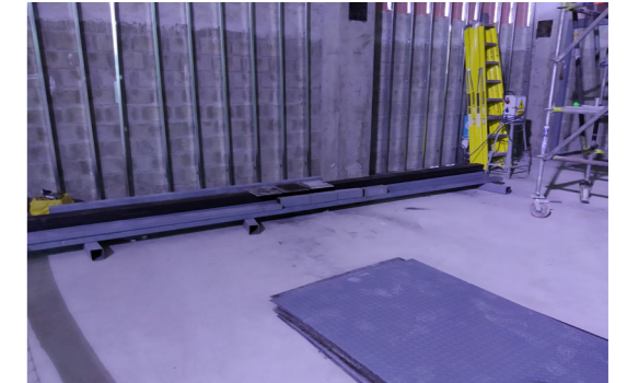
Figura 34: Área de Intervención, Bodega de CAC - 3 Nivel
