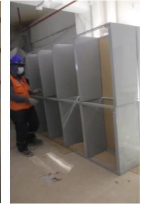
Figura 4: Montaje de Racks Metálicos dentro de Bodega.
