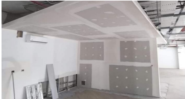
Figura 40: Área de Intervención, Vista de Tabiquería de Drywall en proceso de terminación.
