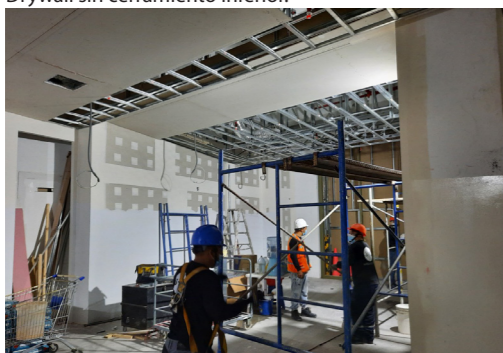
Figura 32: Área de Intervención, Vista de Cielo Raso de Drywall en proceso de cerramiento inferior.
