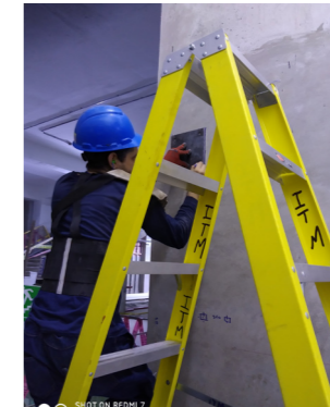
Figura 37: Instalación de Anclaje Tipo 1 y 3 por operario.
