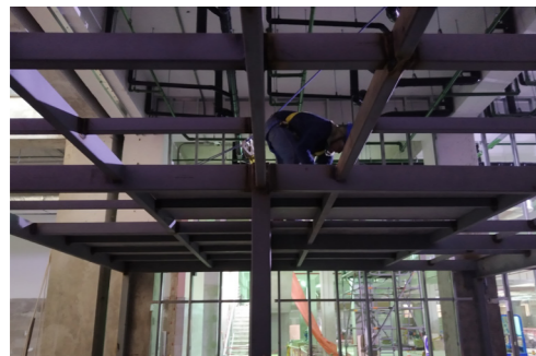
Figura 35: Montaje y fijación de vigas Principales y secundarias.
