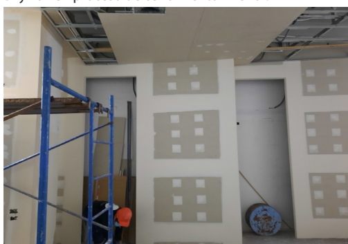
Figura 33: Área de Intervención, Vista de Cielo Raso de Drywall en proceso de cerramiento inferior.
