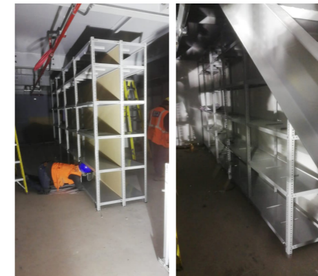
Figura 13: Colocación de Separadores MDF.
