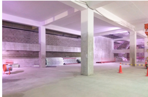
Figura 33: Vista de Área de intervención, previo a la instalación del mezzanine.
