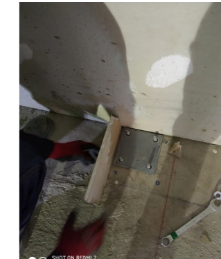
Figura 38: Instalación de Anclaje Tipo 2 por operario.
