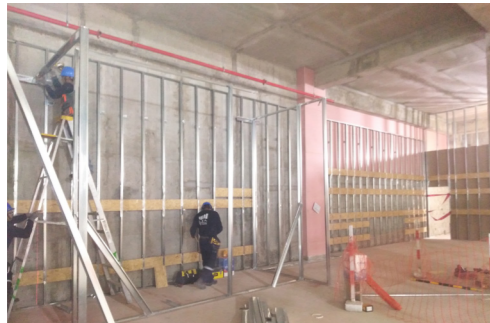
Figura 34: Vista de proceso de Instalación de parantes metálicos.
