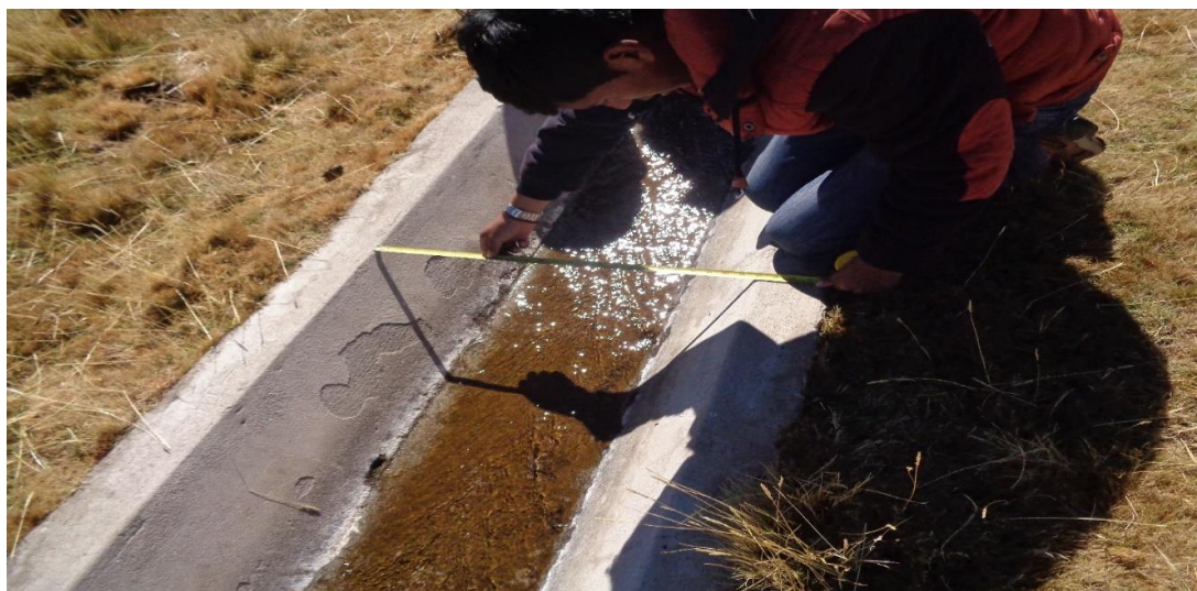
Figura 155. Como se puede apreciar que se está midiendo el canal
