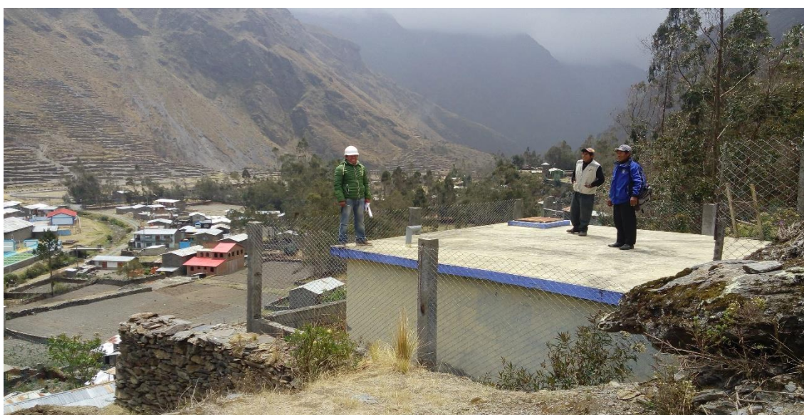
Figura 18. Reservorio de 20 M3 en el sector de Pampa Quiray - Ura Ayllu
