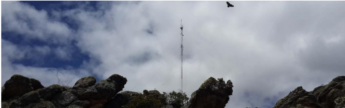
Figura 35. En la presente figura se muestra la torre con las antenas de recepción y transmisión de señal instaladas, dando energía un panel solar con una batería.
