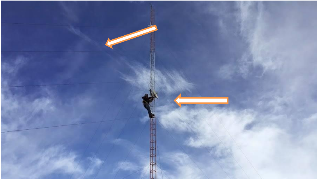
Figura 34. En la presente se muestra la instalación de las antenas ubicadas en la torre donde se recibe y envía señal de internet.
