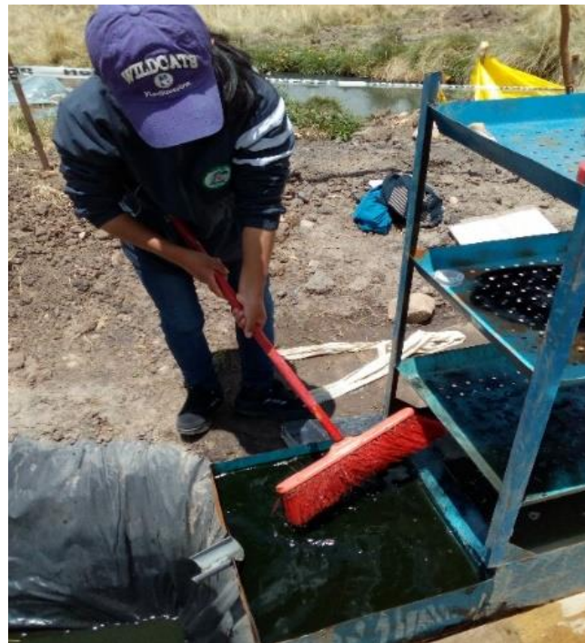
Figura 18. Limpieza de las bandejas de aireación
