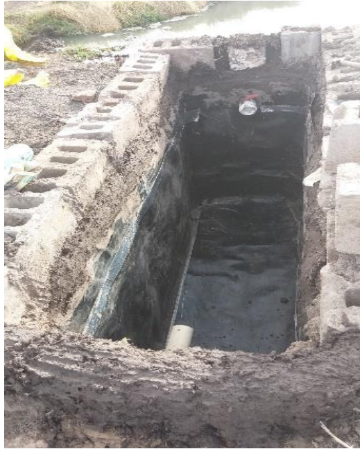
Figura 1. Recubrimiento del tanque séptico con Geomembrana
