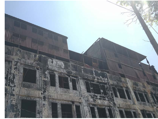
Fig. N° 44: Estructura Modular 2017 - CONTAINERS Fuente: Elaboración Propia
