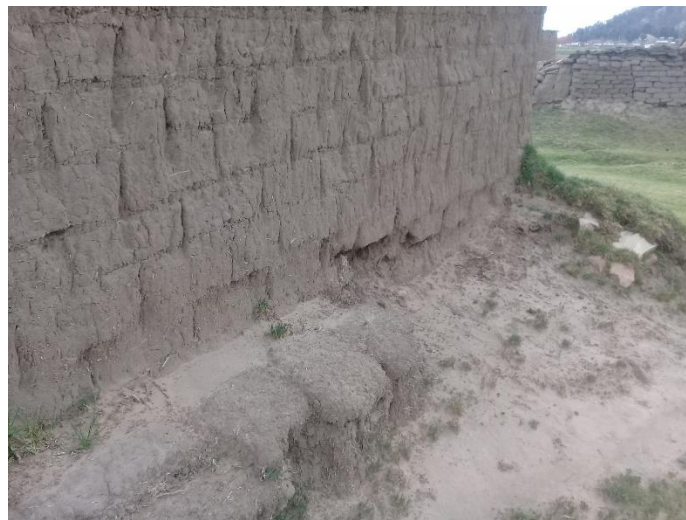
Figura 21. Cimientos con el paso de los tiempos.
