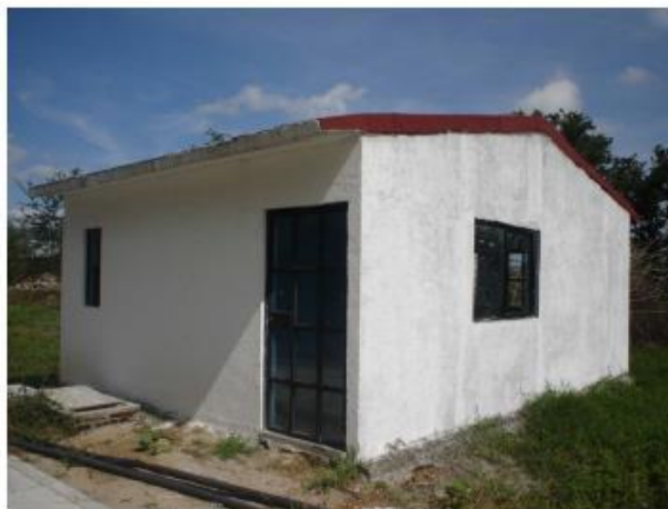
Figura 12. Prototipo de vivienda económica de paneles de ferrocemento.
