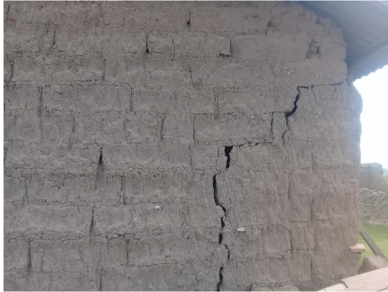
Figura 28. Viviendas en peligro de colapsar.
