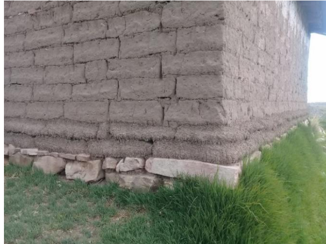
Figura 22. Sobrecimiento típico de viviendas.
