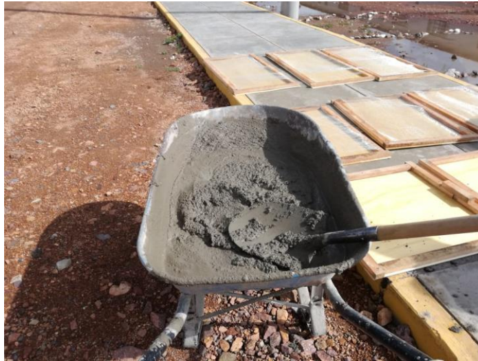
Figura 46. Moldes para el vaciado de concreto.
