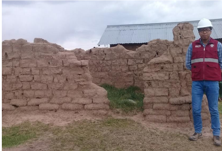
Figura 26. Deterioro de las viviendas con el paso del tiempo.
