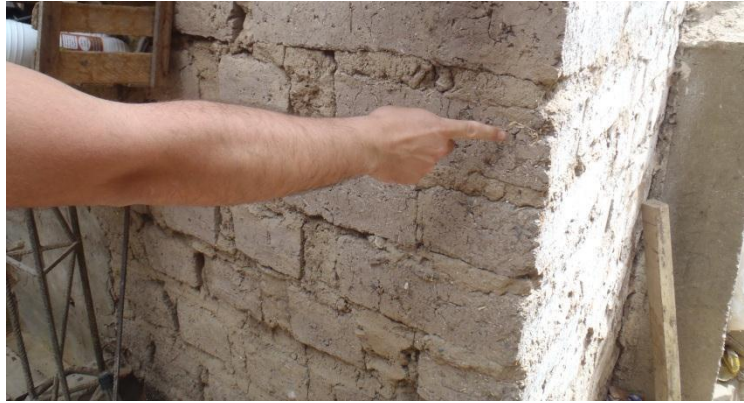
Figura 20. Juntas de 3 cm de espesor.
