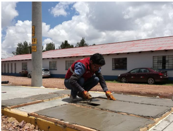
Figura 47. Vaciado de paneles de ferrocemento
