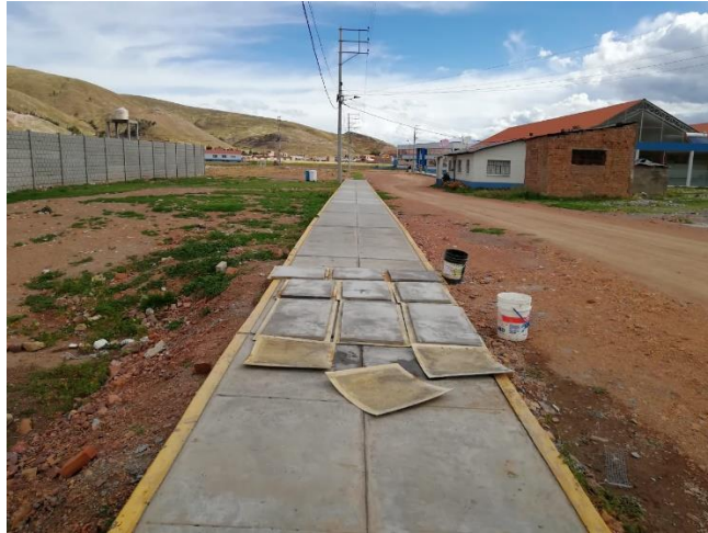
Figura 48. Desencofrado de paneles de ferrocemento.
