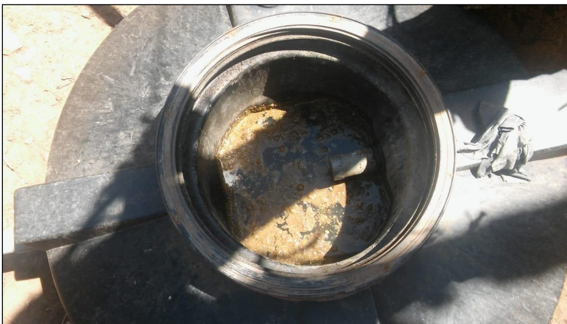
Anexo 7.1 Biodigestor conteniendo el agua residual a tratar
