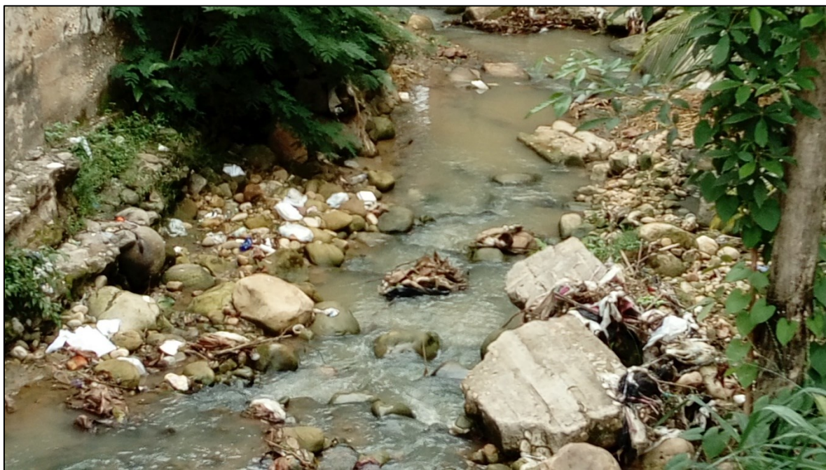
Anexo 5.11. Zona colmatada por mala disposición de residuos sólidos.
