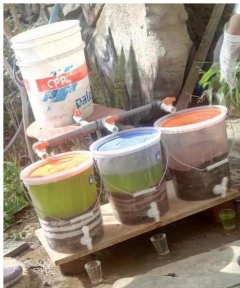
Figura 5. Construcción de los filtros lentos para el sistema de tratamiento
