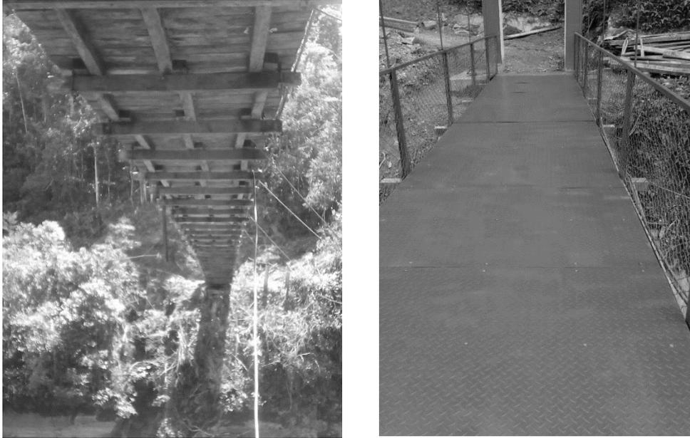
*Figura 14. Tablero de madera y de planchas metálicas, respectivamente
