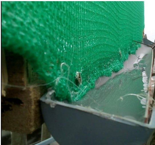
fig. 2 agua acumulada en el Atrapanieblas hexagonal (fuente propia)
