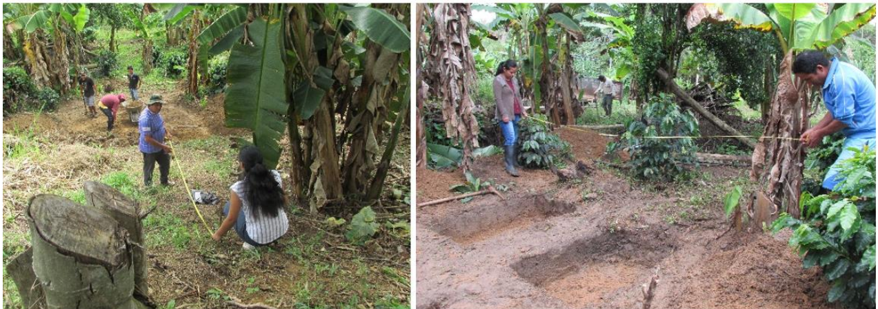
Imagen 2: Trazo de terreno y movimiento de tierra para realizar la construcción.
