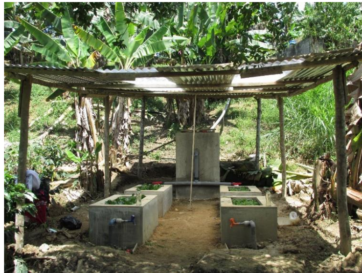
Imagen 10: Sistema de tratamiento de agua residual domestica mediante humedales artificiales con macrófitas flotantes.
