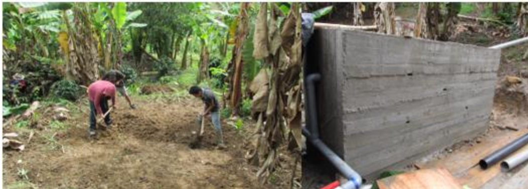
Figura 19: Construcción del tratamiento primario.
