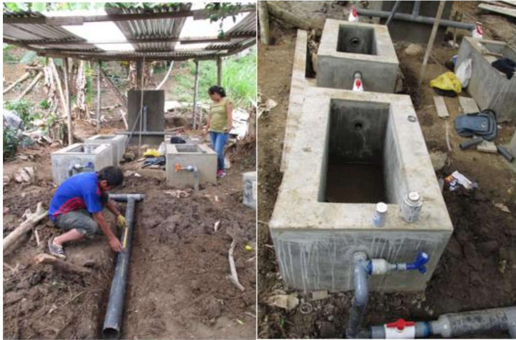
Figura 22: Instalación de tuberías y accesorios.
