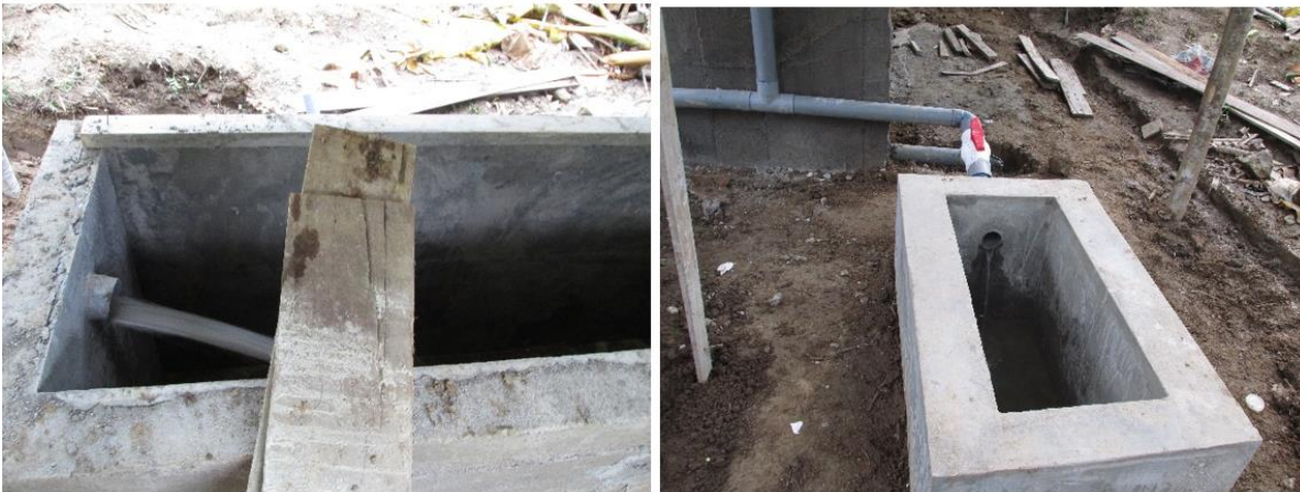
Imagen 5: Prueba hidráulica en el sistema de tratamiento.
