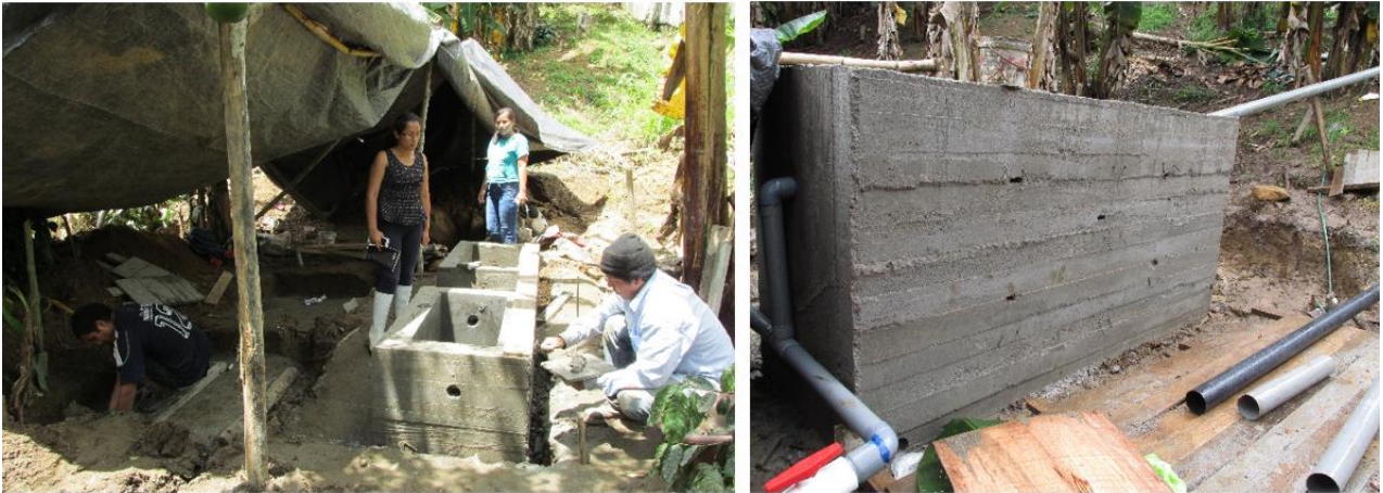
Imagen 3: Construcción de los humedales (tratamiento secundario) y del sedimentador (tratamiento primario).
