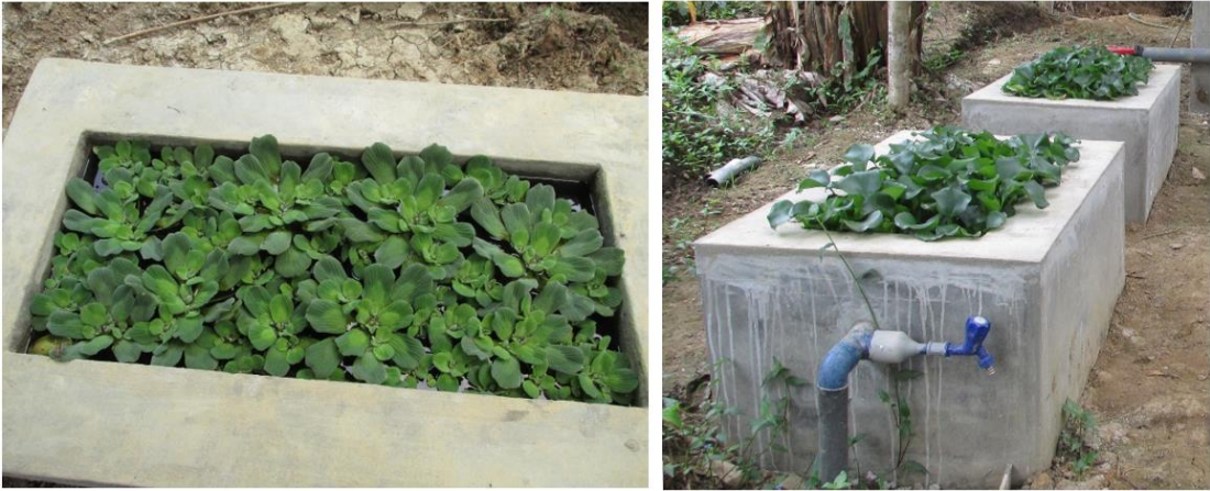
Imagen 19: Humedales artificiales saturadas por las macrófitas debido a su expansión y crecimiento veloz.
