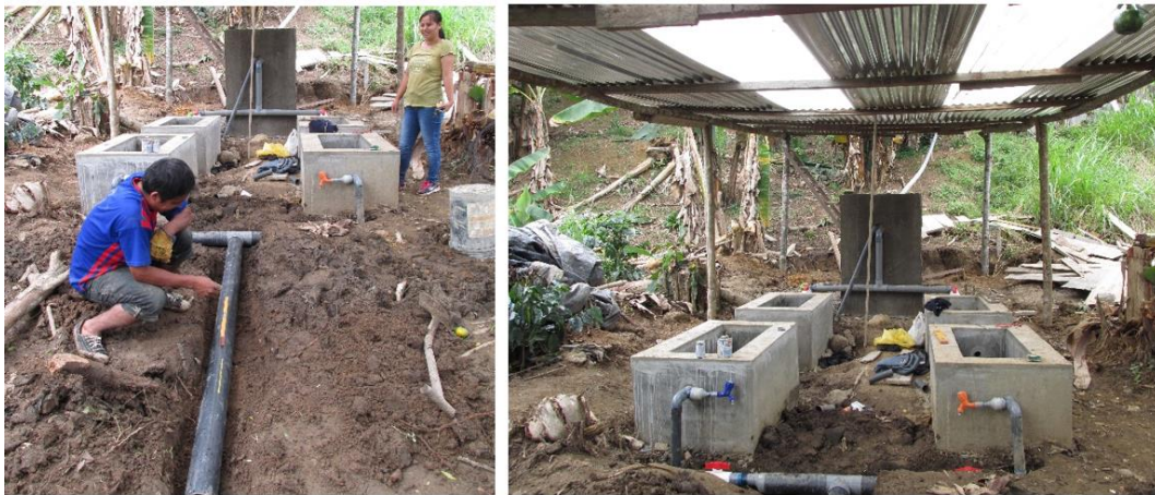
Imagen 4: Instalación de tuberías, accesorios y construcción de la cubierta.
