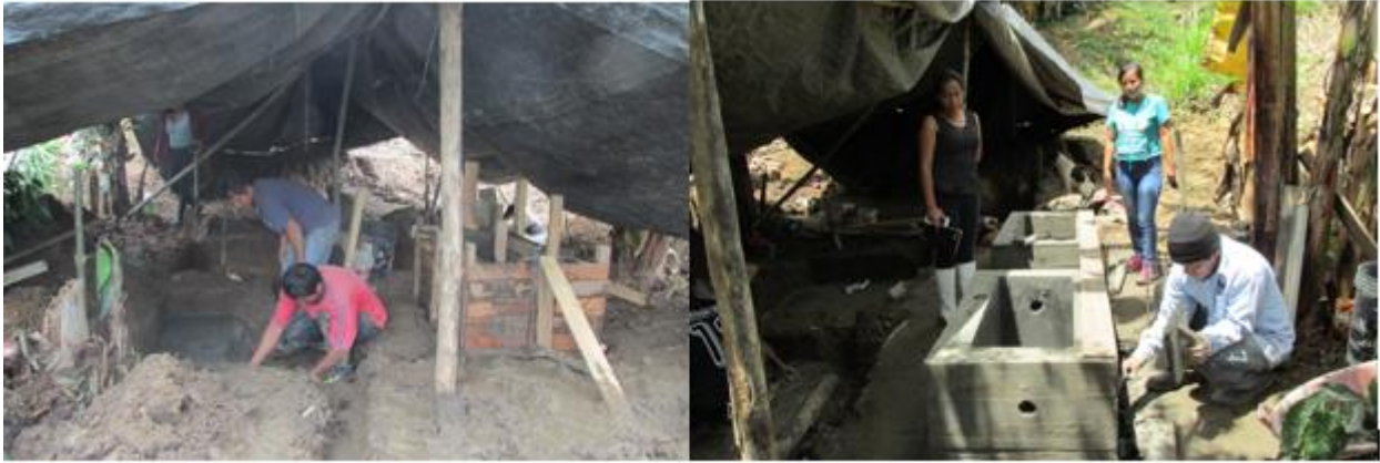
Figura 21: Construcción del tratamiento secundario.
