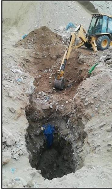
Figura 43. Excavación de la Calicata "A", Profundidad 8.00 m.
