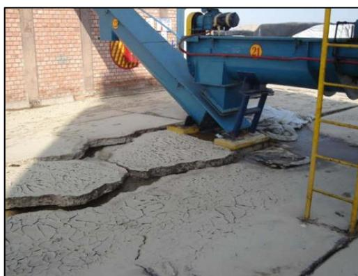
*Figura 9. Levantamiento y deformación a causa de la Licuación de suelos, Pisco, 2007. (Fuente: Carrillo y Alcayhuaman, 2008, pág. 2)*
