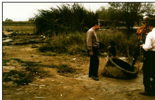
*Figura 6. Buzones de desagüe emergiendo a la superficie por efectos de la licuación Moyobamba, 1990 y 1991. (Fuente: Alva Hurtado, 2011)*
