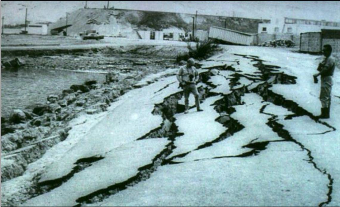
*Figura 8. Asentamientos y fisuramientos de la carretera Panamericana por efecto del fenómeno de Licuación de suelos en Chimbote, 1970. (Fuente: Hurtado, A. y Parra, D., 2011)*
