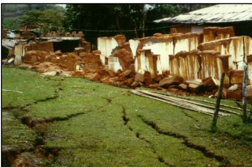
*Figura 7. Derrumbes de viviendas por efectos de licuación, Moyobamba, 1990 y 1991. (Fuente: Alva Hurtado, 2011)*
