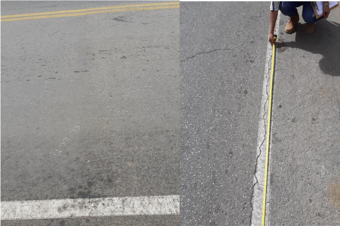
Figura 90: Fisuras transversales y peladura por intemperismo, unidad de muestreo U21
