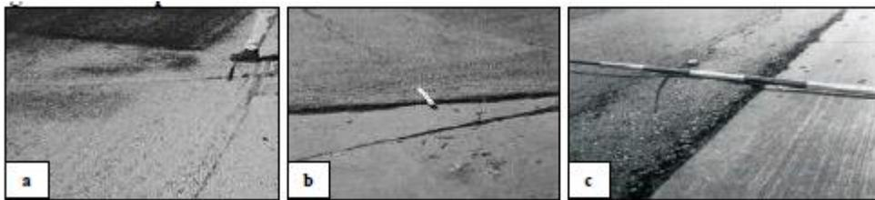
Figura 21:Desplazamiento de nivel de gravedad bajo (a), medio (b) y alto (c).
