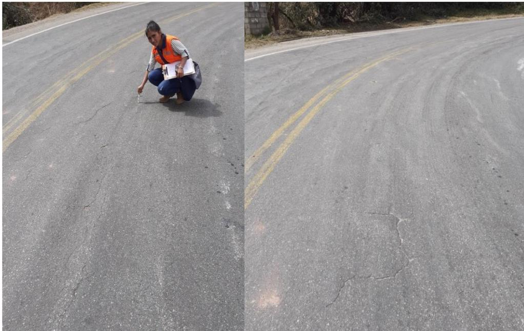
Figura 92: Fisuras transversales y peladura por intemperismo, unidad de muestreo U23
