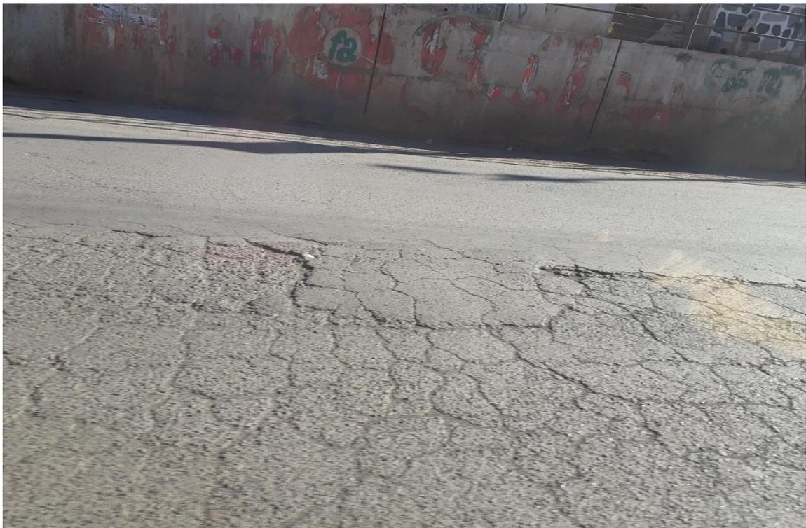
Figura 113:Piel de cocodrilo y fisuras en bloque, unidades de muestreo U24 y U25
