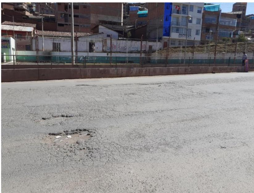
Figura 54: Piel de cocodrilo y fisuras en bloque, unidad de muestreo U19
