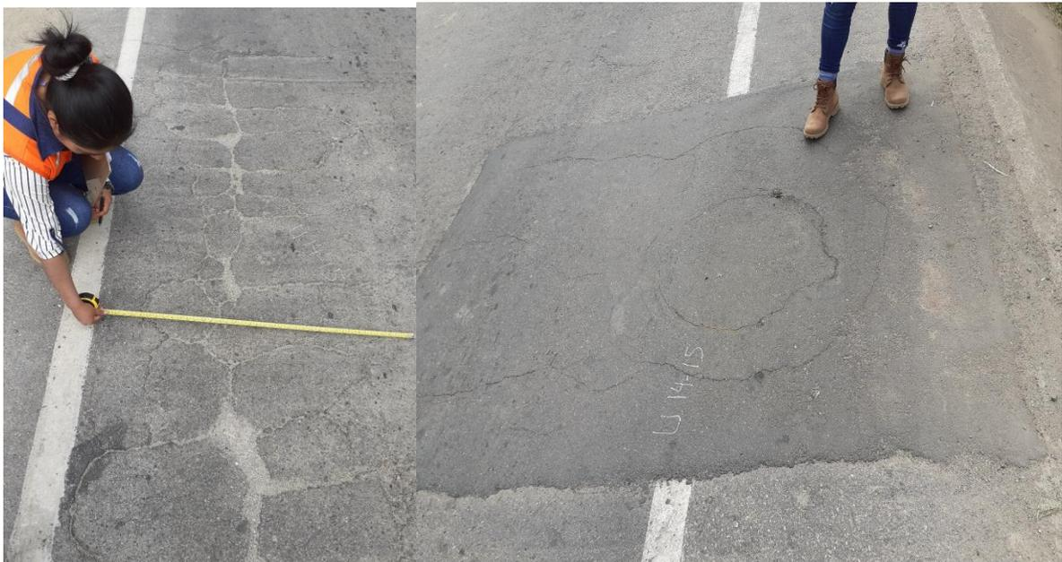
Figura 51: Fisuras en bloque y Parche, unidades de muestreo U16
