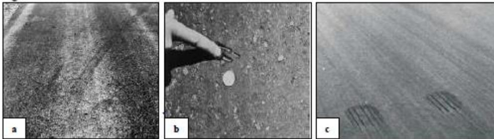
Figura 10: Exudación de nivel de gravedad bajo (a), medio (b) y alto (c).
