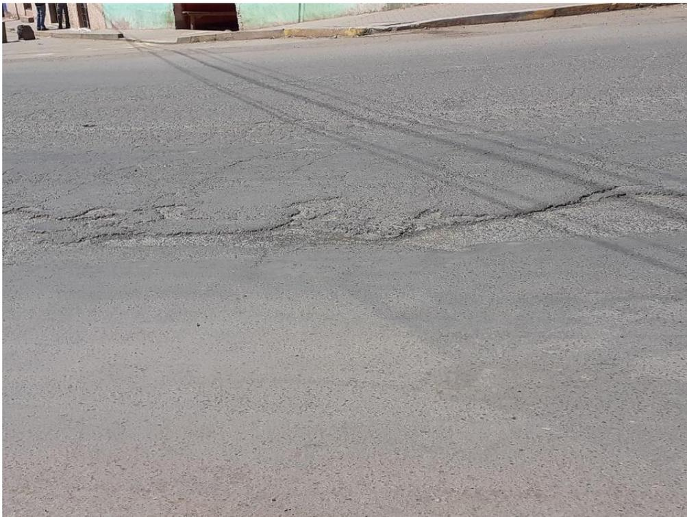
Figura 101: Piel de cocodrilo y peladura por intemperismo, unidad de muestreo U8
