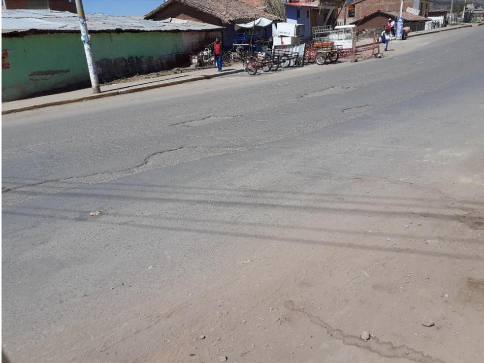
Figura 102: Piel de cocodrilo y peladura por intemperismo, unidad de muestreo U9
