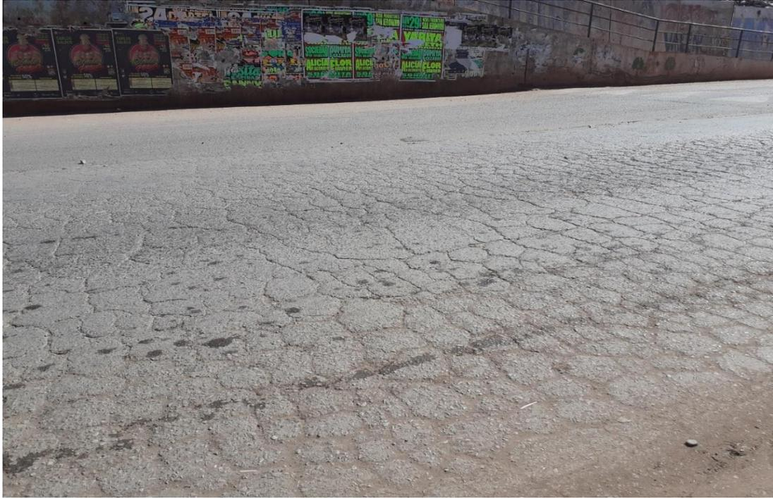
Figura 112:Piel de cocodrilo y fisuras en bloque, unidades de muestreo U22 y U23
