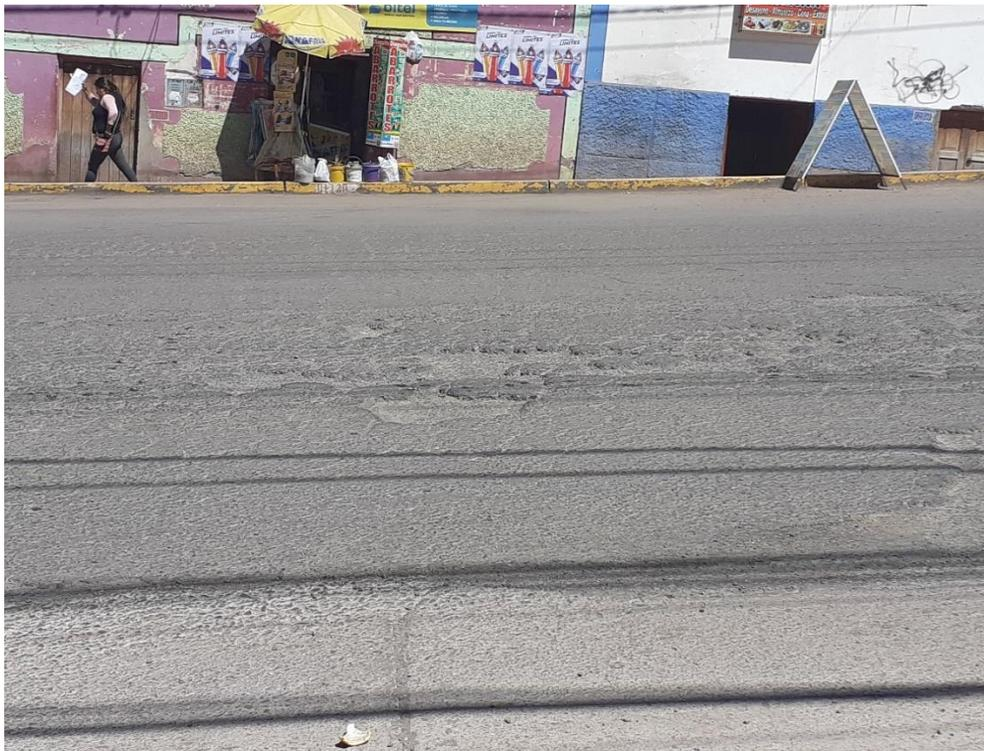
Figura 99: Fisuras en bloque y peladura por intemperismo, unidad de muestreo U5
