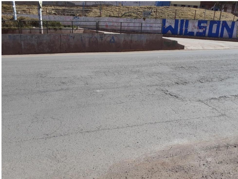
Figura 109:Piel de cocodrilo y peladura por intemperismo. Unidad de muestreo U17
