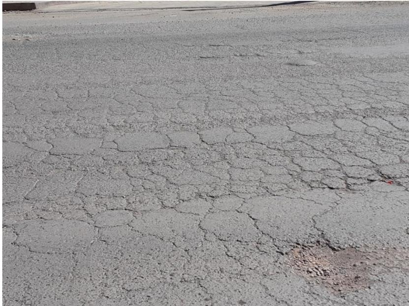
Figura 53: Piel de cocodrilo y fisuras en bloque, unidad de muestreo U11
