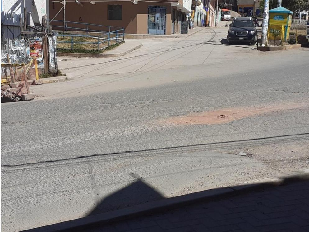
Figura 100: Piel de cocodrilo y peladura por intemperismo, unidad de muestreo U6
