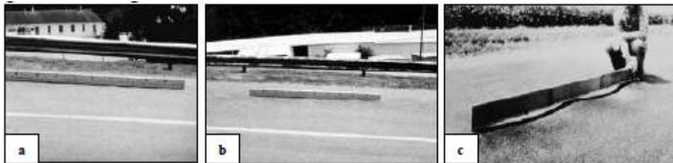
Figura 13: Corrugación de nivel de gravedad bajo (a), medio (b) y alto (c).
