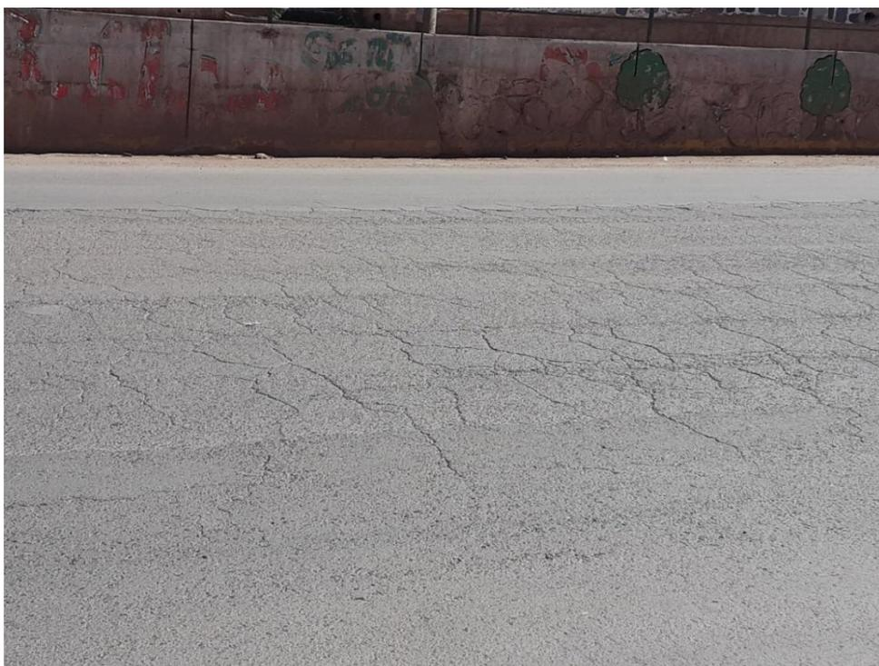
Figura 110:Piel de cocodrilo y fisuras en bloque, unidad de muestreo U18
