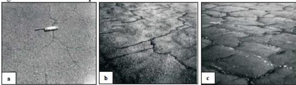
Figura 11: Fisuras en bloques de niveles de gravedad bajo(a), medio(b) y alto(c).
