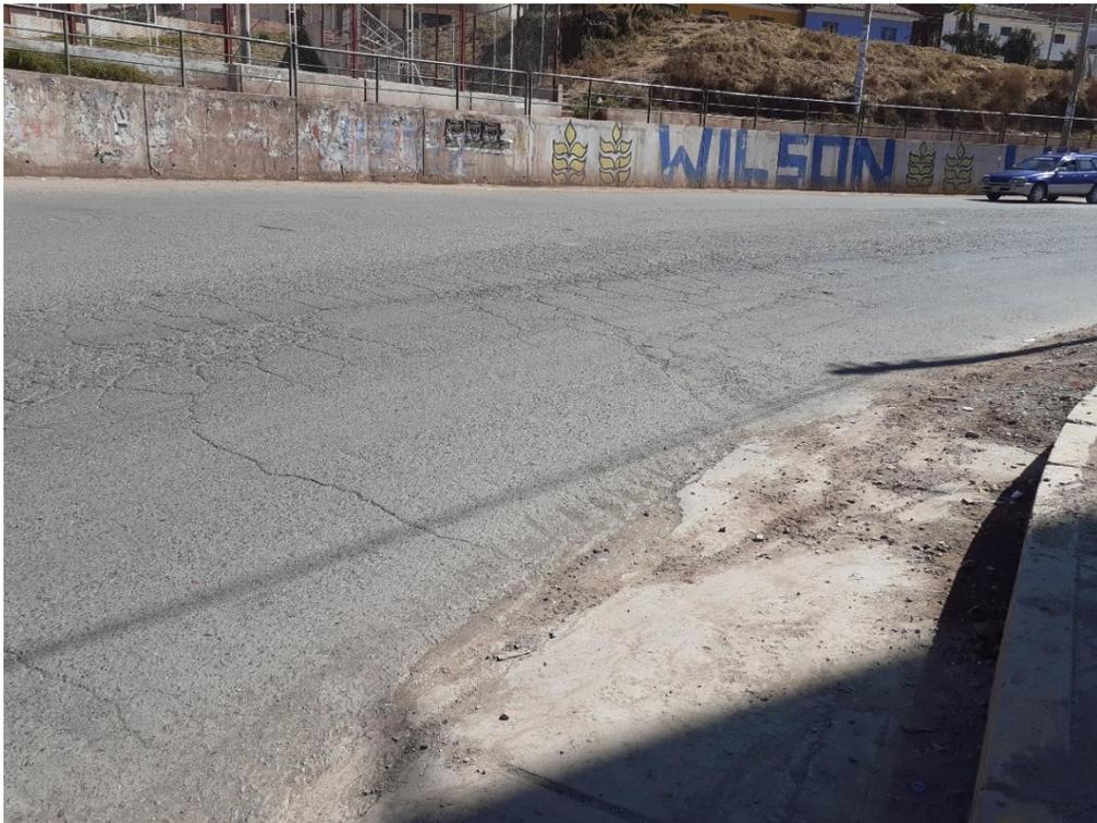
Figura 107: Piel de cocodrilo y fisuras en bloque, unidad de muestreo U15
