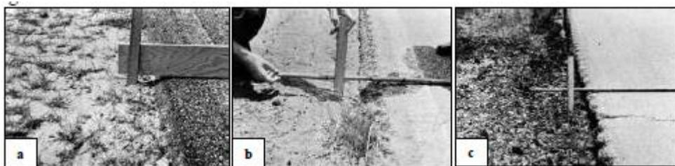
Figura 16: Desnivel carril-berma de nivel de gravedad bajo(a), medio(b) y alto(c).
