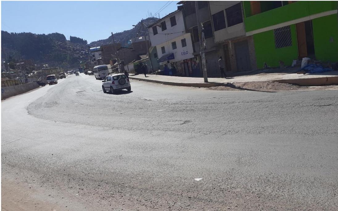
Figura 105: Piel de cocodrilo y peladura por intemperismo, unidad de muestreo U13
