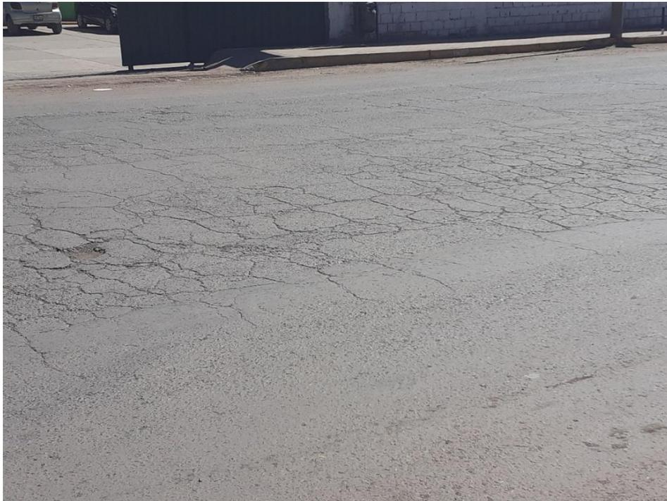
Figura 103: Fisuras en bloque y peladura por intemperismo, unidad de muestreo U10
