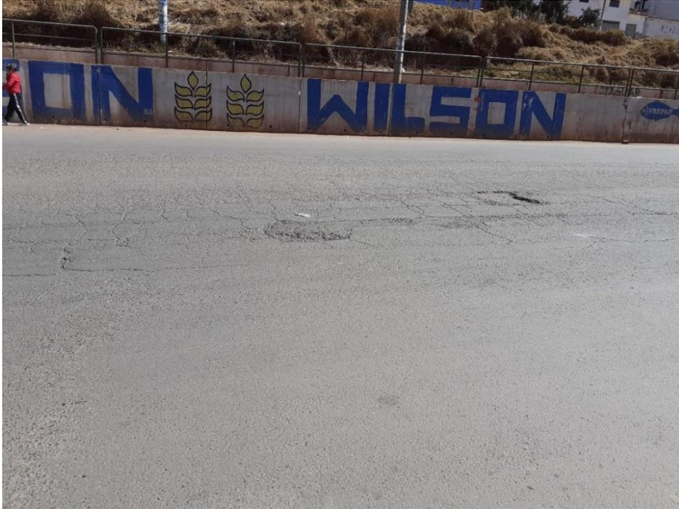
Figura 108:Piel de cocodrilo y fisuras en bloque, unidad de muestreo U16
