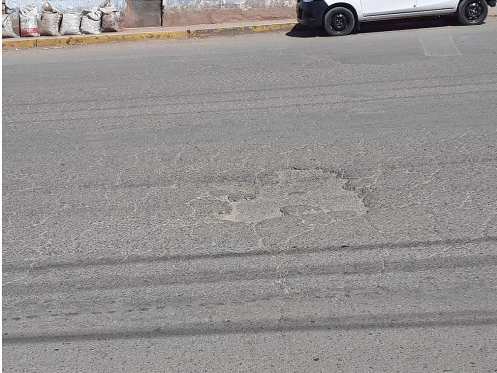
Figura 98: Piel de cocodrilo y fisura en bloque, unidad de muestreo U4
