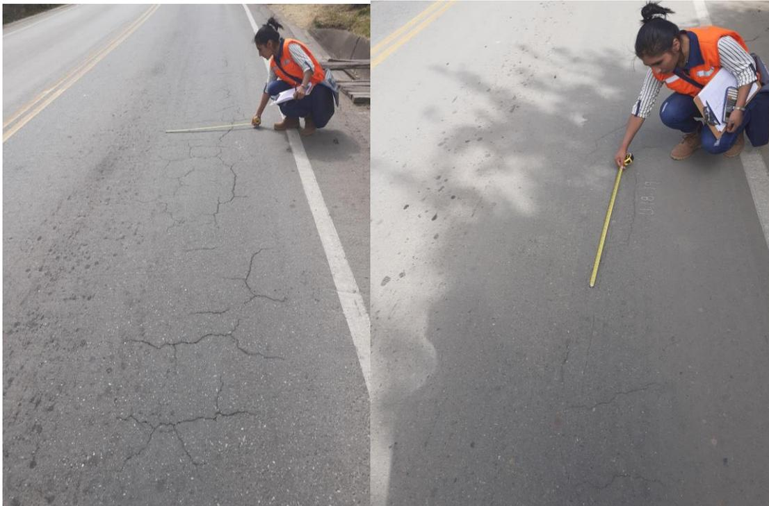
Figura 88: Fisuras longitudinales y Fisuras en bloque, unidad de muestreo U18
