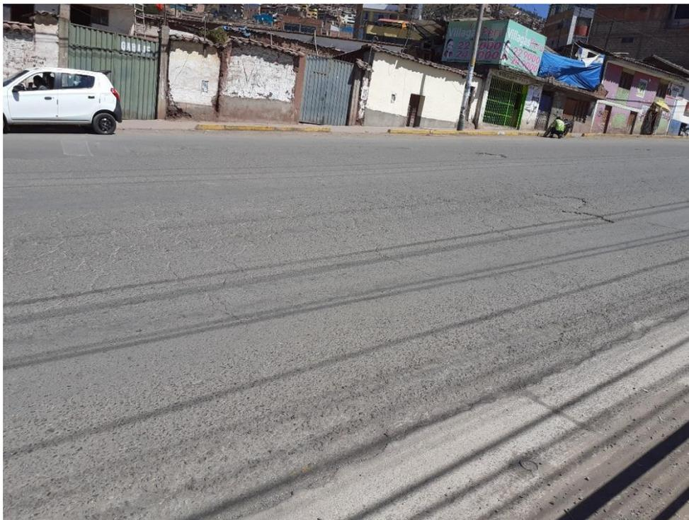
Figura 97: Piel de cocodrilo y peladura por intemperismo, unidad de muestreo U3
