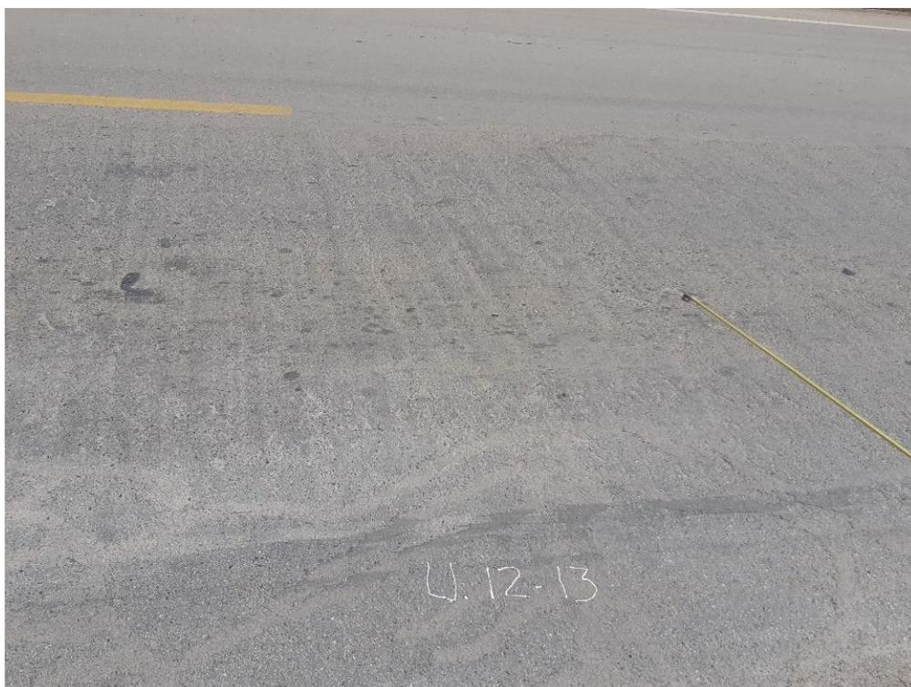
Figura 85: Fisuras parabólicas, unidad de muestreo U13
