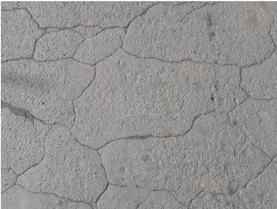
Figura 80: Fisuras en bloque, unidad de muestreo U2
