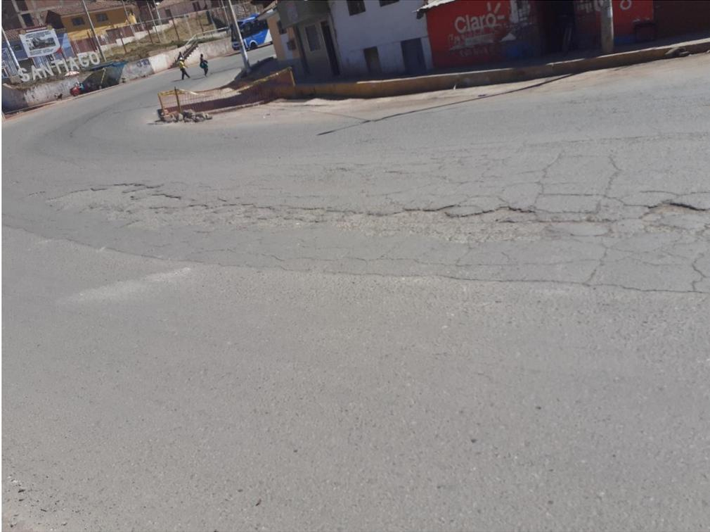
Figura 104: Fisuras en bloque y peladura por intemperismo, unidad de muestreo U12
