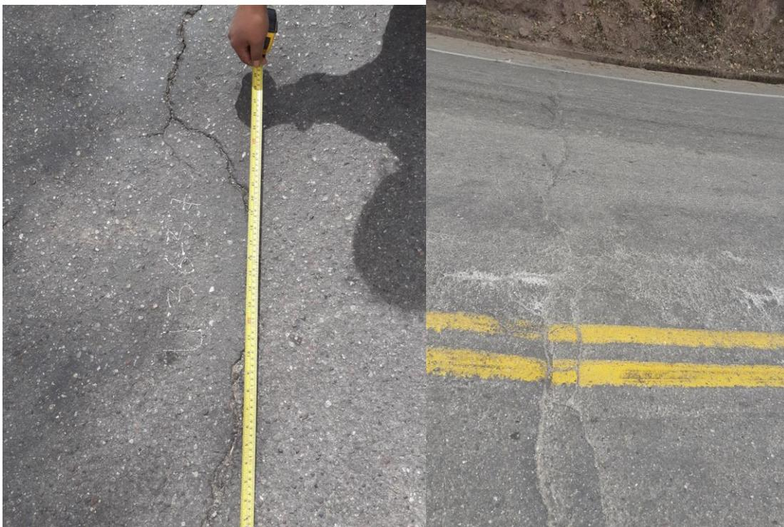
Figura 91: Fisuras longitudinales y hundimiento, unidad de muestreo U22
