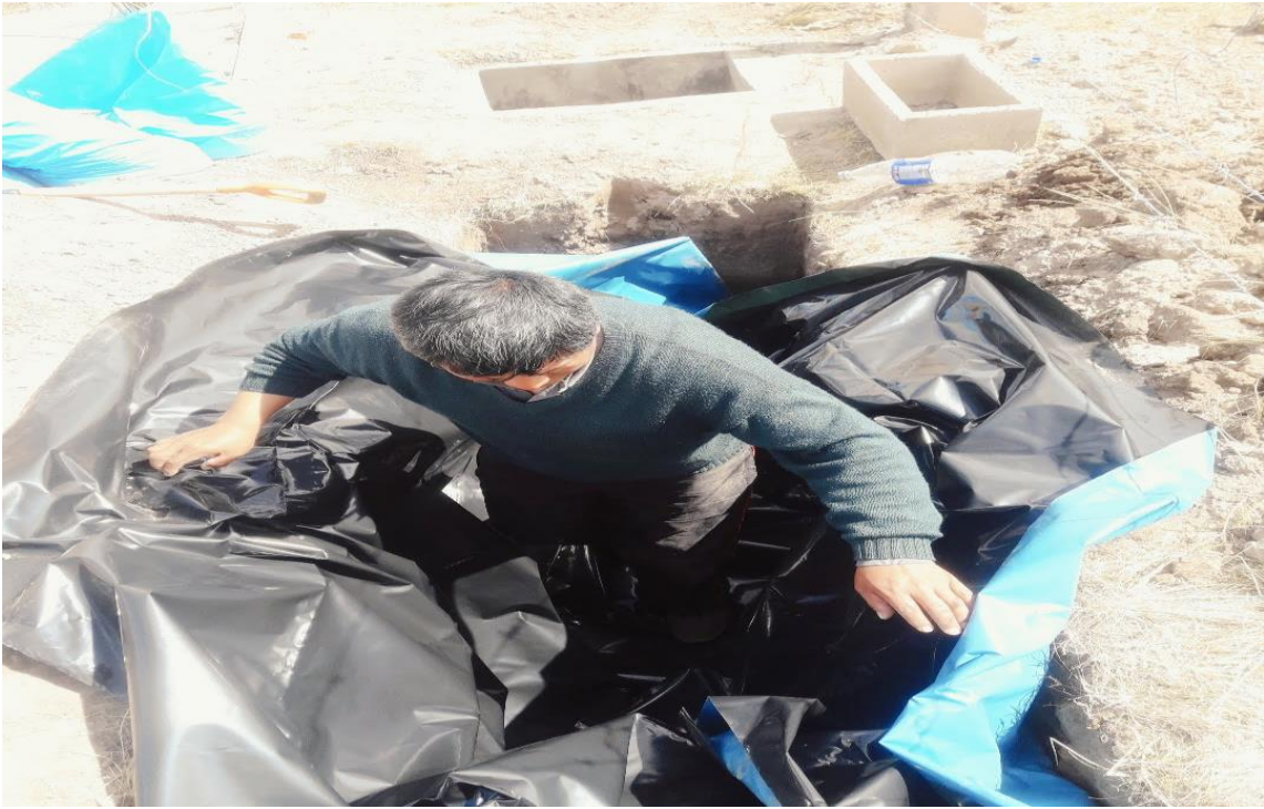
Figura 12. Revestimiento con plástico al HAFSH
