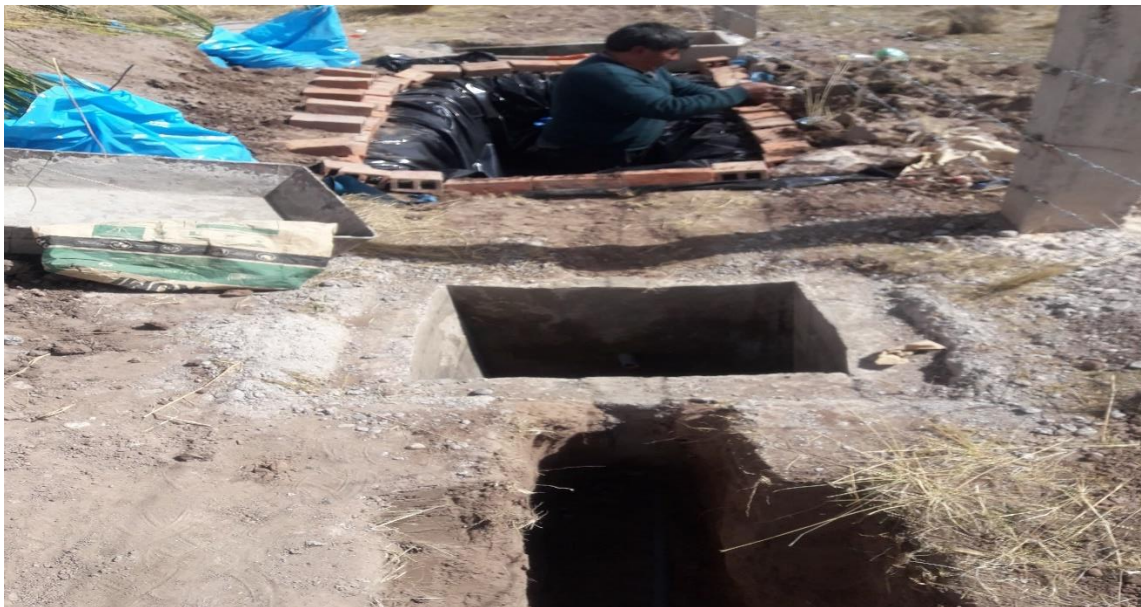
Figura 13. Cerco perimétrico de ladrillo alrededor del humedal para evitar que el lecho filtrante arrastre al plástico
