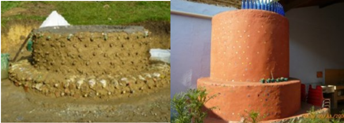
Figura 10. Construcción de tanques artesanales para agua (Gonzales & Rodas, 2015).
