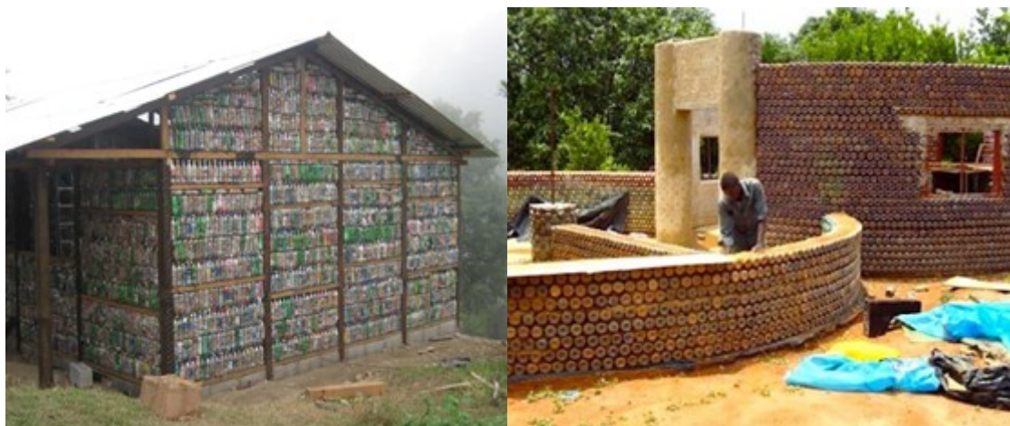
Figura 7. Infraestructura de viviendas en Guatemala (Gonzales & Rodas, 2015).
