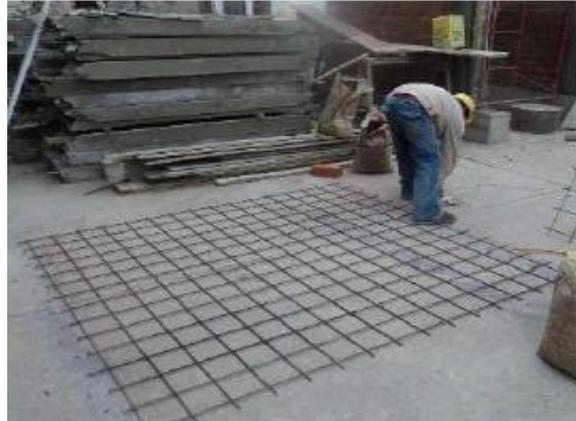
*Figura 1: Malla electrosoldada empleada para mejorar la resistencia de los muros.*
