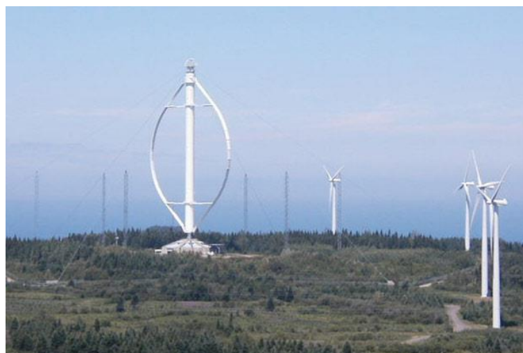
Figura 5. Orientación del rotor vertical y Horizontal. (2020). Recuperado 18 de noviembre de 2020, de https://www.renovablesverdes.com/como-transportas-las-palas-de-52metros-de-un-aerogenerador/
