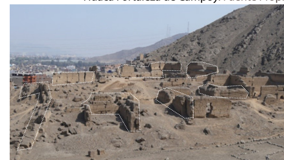
Figura 026: Muros doble - segunda etapa de construcción. Fuente Propia.
