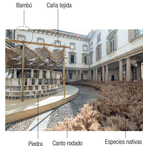
Figura 051: Materiales utilizados en Courtyard Village. Fuente: Editado a partir de Arch Daily Perú 2016
