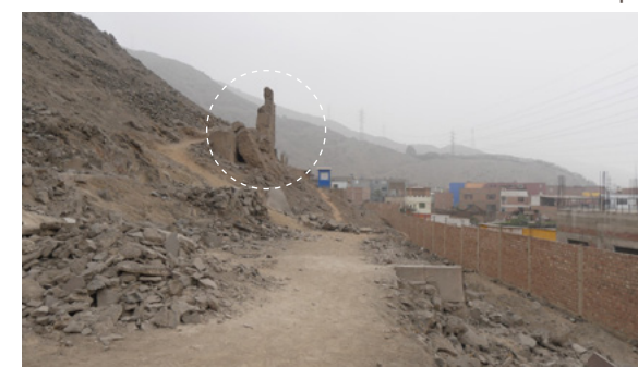
Figura 027: Posible camino epimural - tercera etapa de construcción. Fuente Propia.
