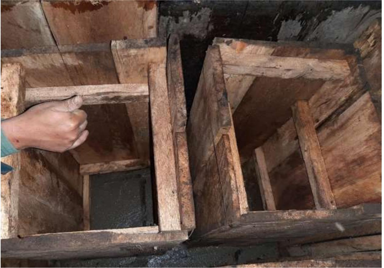
Anexo 5.2 Etapa de encofrado para la construcción de los filtros
