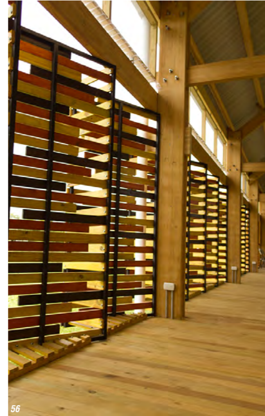
Figura 158. Detalle de celosía. Kāpāclājūi. Fuente: Archdaily.com
