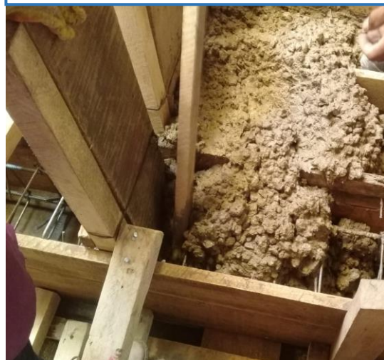
Imagen N°39: Vaciado de las vigas
