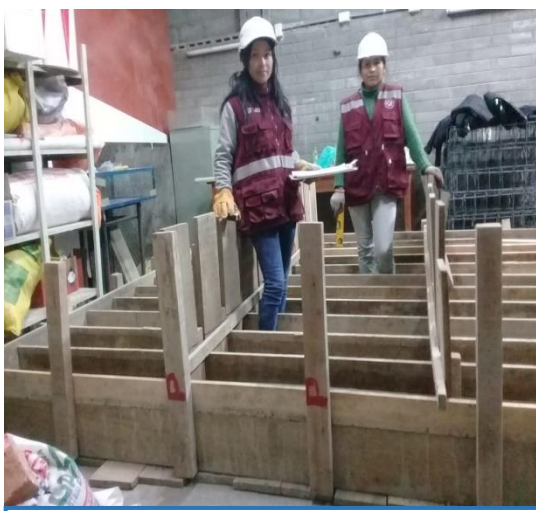
Imagen N°33: Nivelación de encofrado
