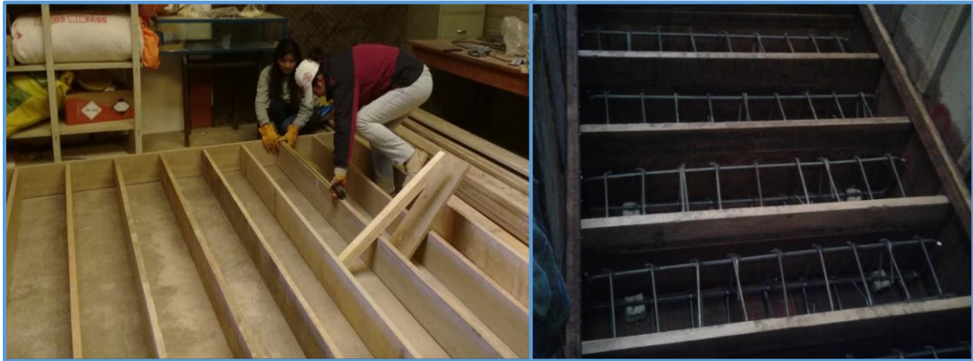
Figura 32. Encofrado y montaje.
