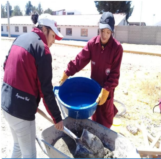
Imagen N°31: Preparación de concreto para los dados
