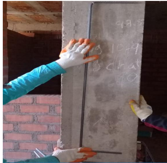
Imagen N°26: Doblado de aceros longitudinales
