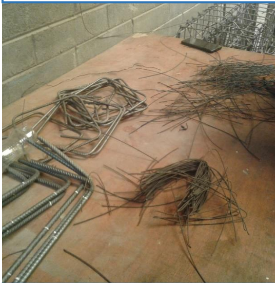
Imagen N°27: Estribos y aceros longitudinales
