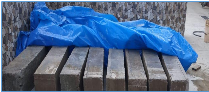
Figura 34. Curado de las vigas.
