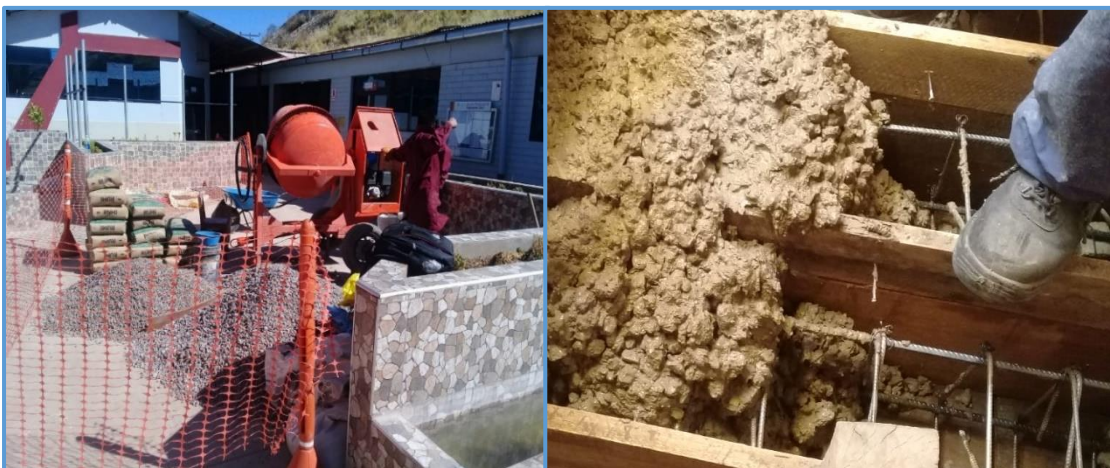
Figura 33. Colocado del concreto.
