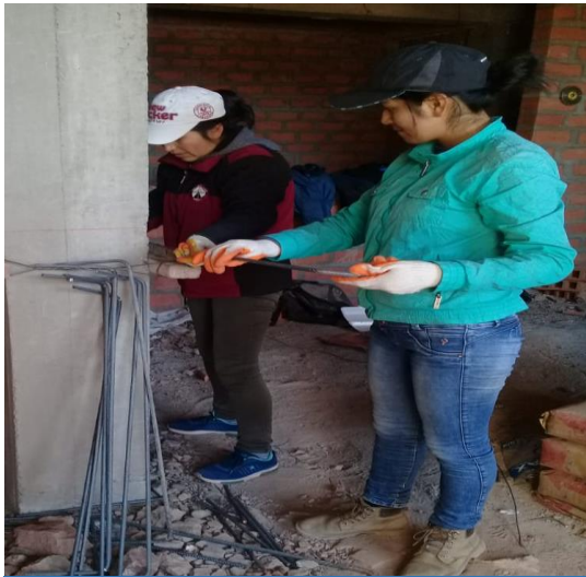
Imagen N°25: Doblado de estribos para las vigas de concreto armado
