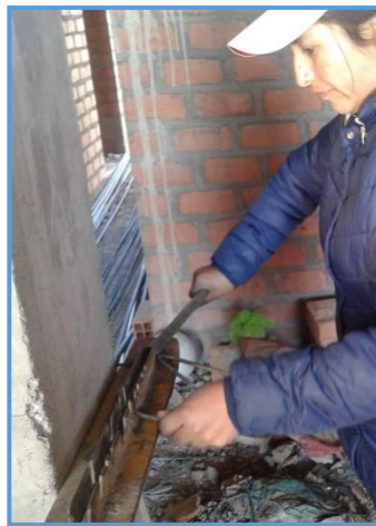
Figura 30. Dobles del estribo
