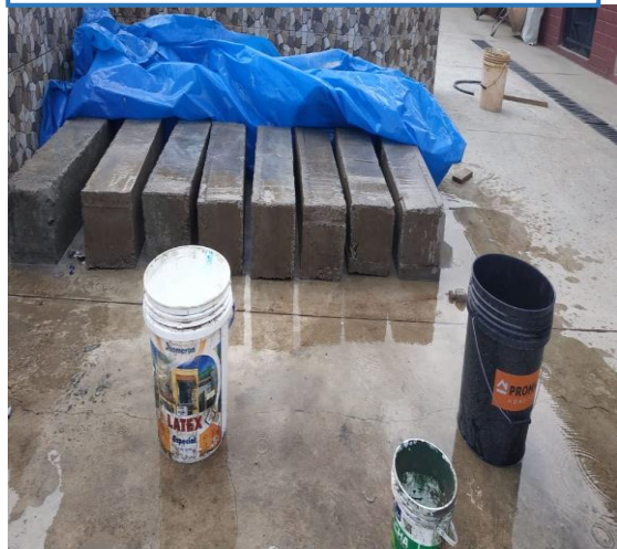
Imagen N°40: Curado de las vigas
