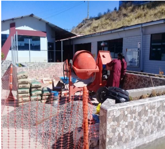
Imagen N°37: Preparación del concreto f'c 210 kg/cm2 para el vaciado de las vigas
