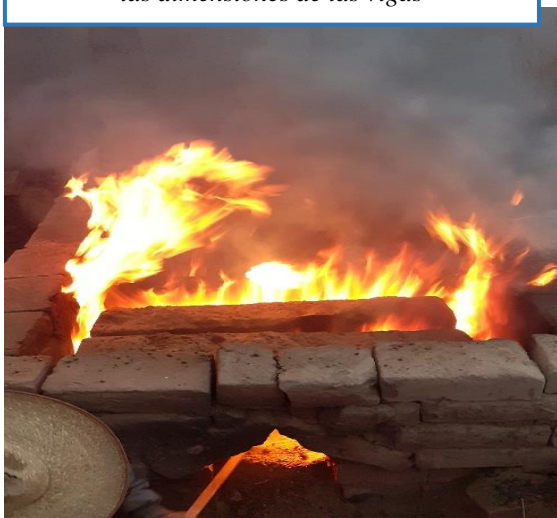
Imagen N°47: Vigas expuestas a fuego
