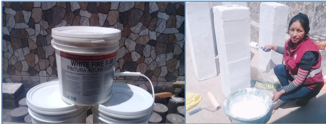
Figura 35. Aplicación de la pintura intumescente.
