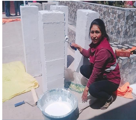
Imagen N°44: superficialmente con pintura intumescente
