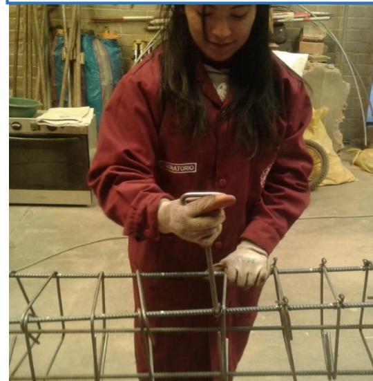
Imagen N°28: Colocado de los estribos
