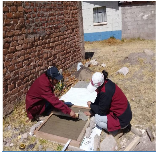
Imagen N°32: Dados de concreto
