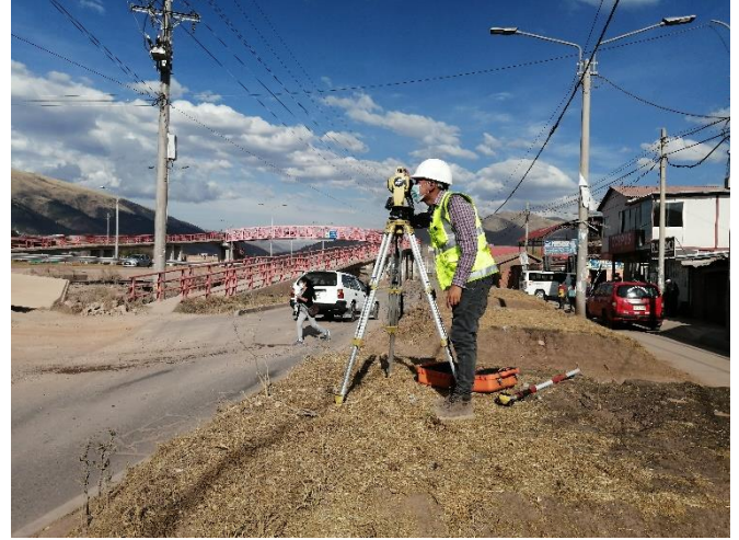
Fotografía 1. Levantamiento topográfico con estación total en los TCA.
