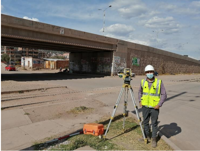
Fotografía 1. Levantamiento topográfico con estación total en los TCA.
